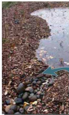
Kameňmi vydláždený odtok
