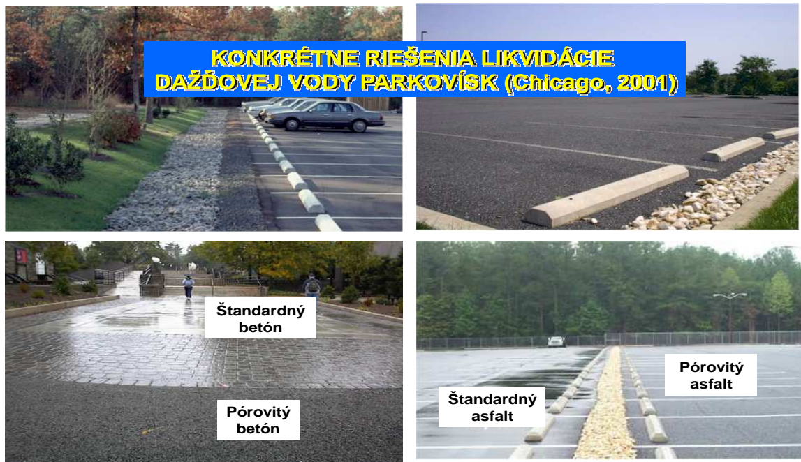
Obr.: Konkrétne riešenia likvidácie dažďových vôd z parkovísk s možnosťou vsaku pod spevnený povrch 57 .
