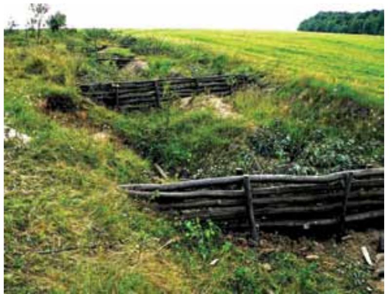
Najlepšou ochranou pred eróziou v horských stržiach sú hrádzky s otvormi, ktoré sa postupne zanesú. | The best protection against erosion are check dams with slits that will get clogged gradually.
