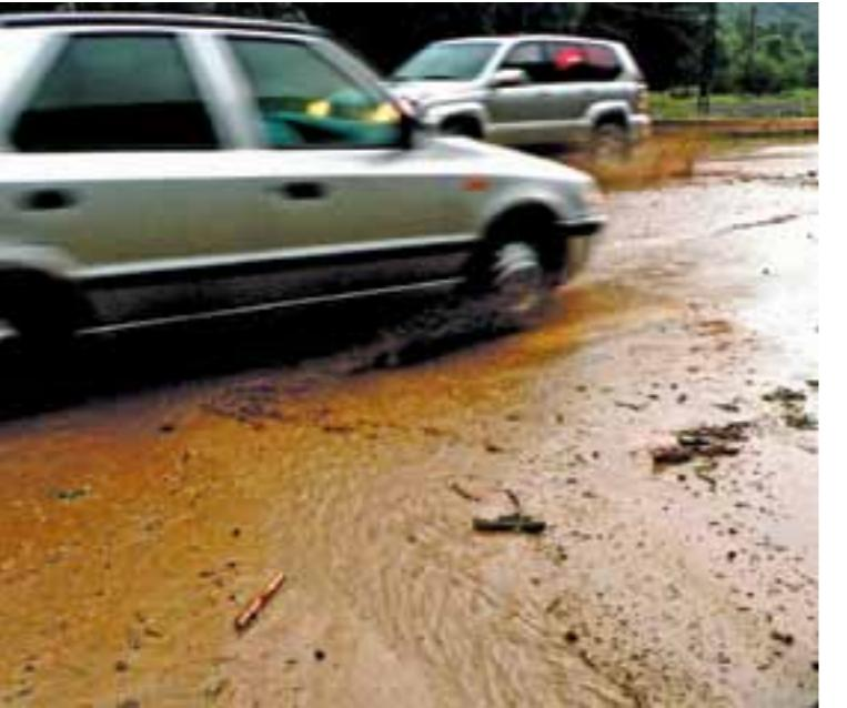
Bahenná záplava štátnej cesty pod Strečnom z lesných ciest v povodí Váhu. Mud and water flowing from the forest roads caused flood on a state road under Strečno in the Váh river basin.
