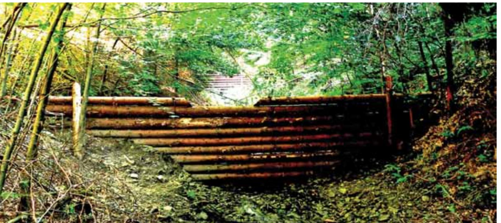
**Kaskády hrádzok z odpadového i neolúpaného dreva zadržia pôdu i štrky, ktoré nesťečú do údolia Malej Lodiny, Jakuban či Zázrivej.** | The cascades of check dams built of waste wood and timber covered in bark will retain soil and gravel in the hills and prevent it from being carried down to the valleys in Malá Lodina, Jakubany and Zázrivá.
