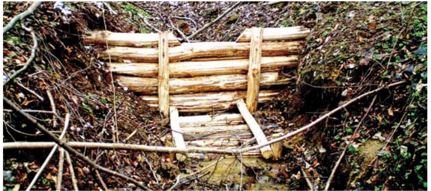
**Odkôrnené drevo na hrádzke vydrží oveľa dlhšie ako neodkôrnené.** | Debarked timber on check dams will last much longer than wood covered in bark.
