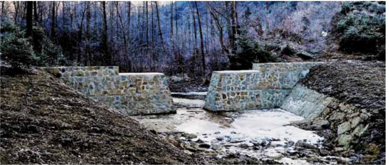
Môže mať otvor, siahajúci až na dno, ako v Oščadnici. | It can feature an opening reaching down to the riverbed as the one in Oščadnica.
