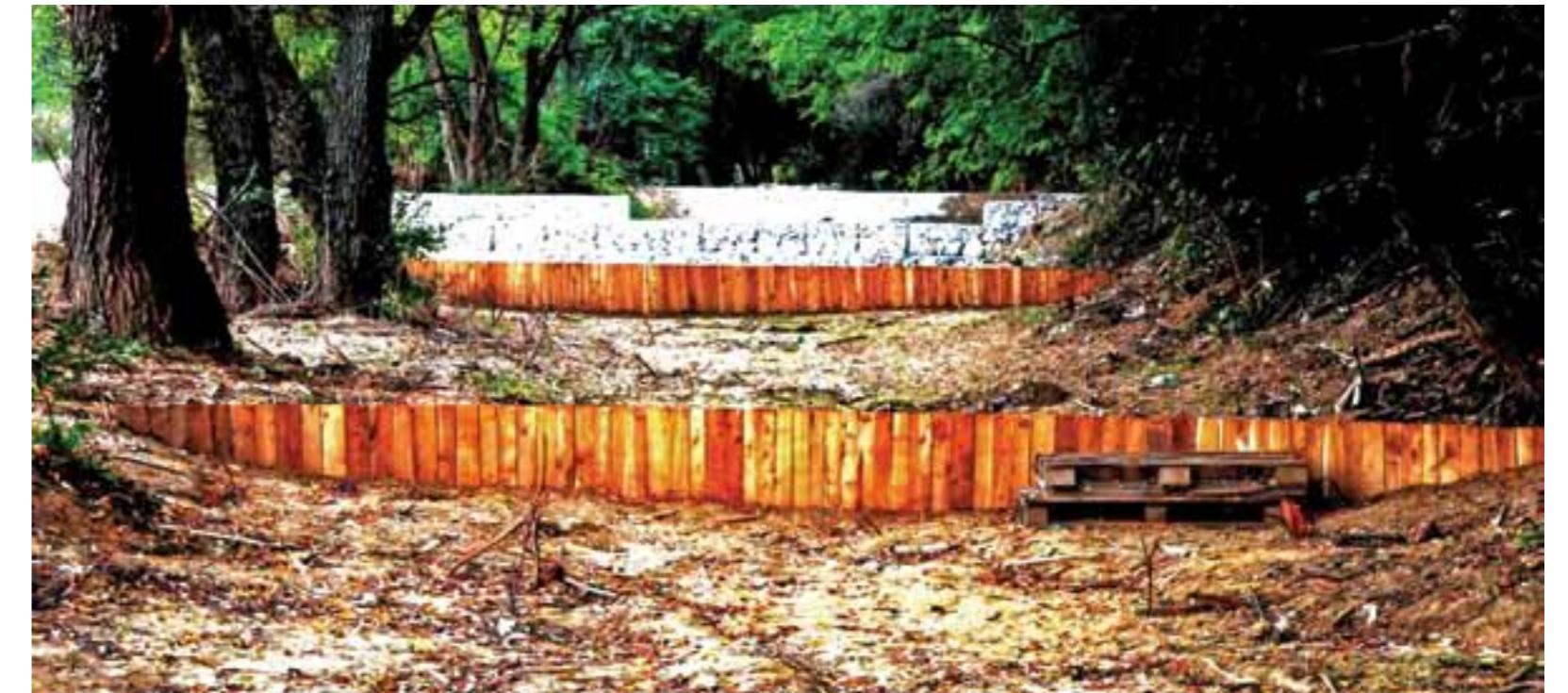
**Typy kombinovaných hrádzí v Hornom Hričove, Hlohovci a Mýtnej v kombinácii s oceľovými profilm i vŕbovým zápletom.**
