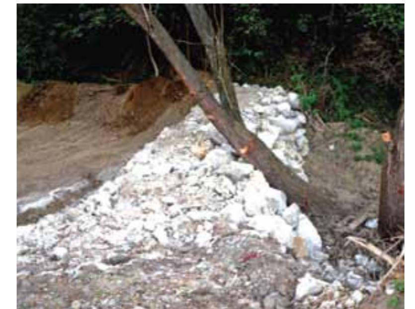
**Vodozádržný objem kamennej hrádze závisí od výšky a sklonu dna.**
