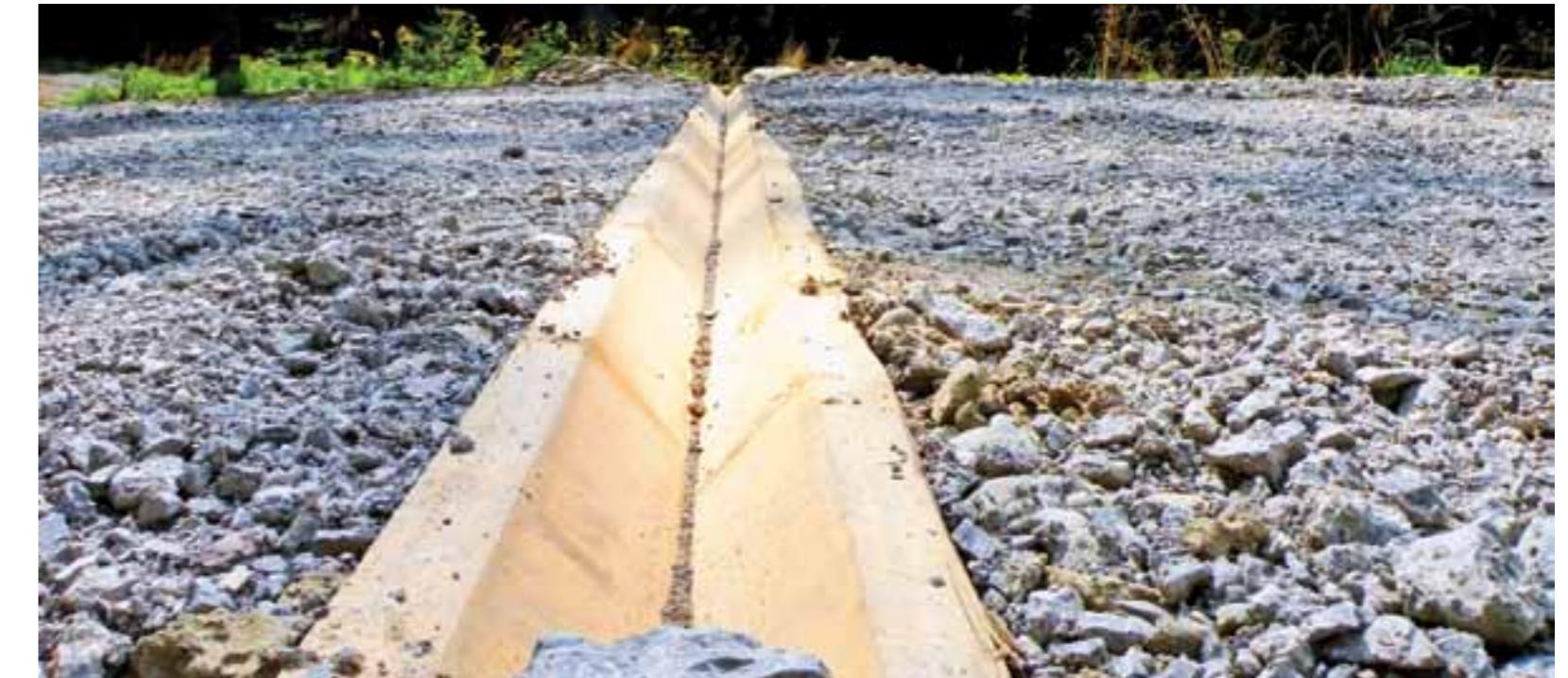
Je dobré, ak tvar odrážky dokáže odplavovať jemné sedimenty z nej. | It is good if the profile of surface cross drains is able to carry fine sediment away from it.
