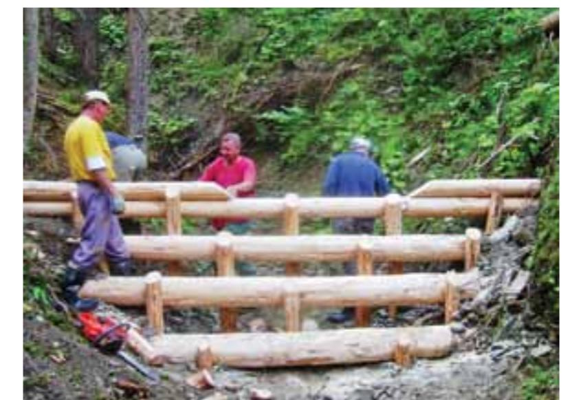
**Prvým krokom výstavby prekladanej hrádze bolo urobiť kostru z kôry zbaveného dreva dostatočne zakotvenú v rokline.** | The first step in constructing the interlaced check dam was to build a skeleton from debarked wood properly anchored in the gully.
