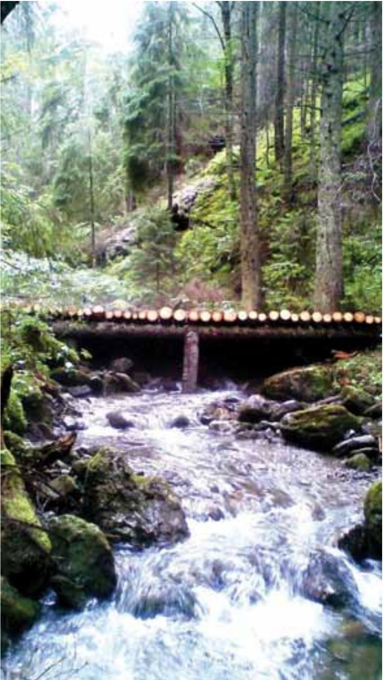
Účelom kolových hrádzí rôzneho typu je zachytávať konáre, lístie, sedimenty i vzdúvať hladinu pri prechode povodňovej vlny.
