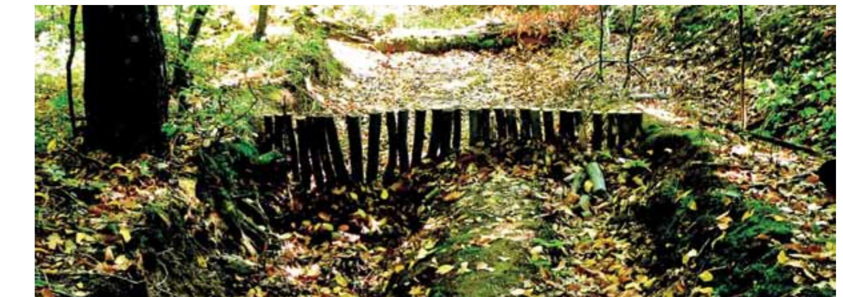
Účinné kolové hrádzky štartujú proces likvidácie lesnej zvážnice vegetáciou zadržaním lístia, sedimentov a dažďovej vody. Effective stake check dams initiate the process of elimination of the old wood haulage way by retaining leaves, sediment and rainwater.
