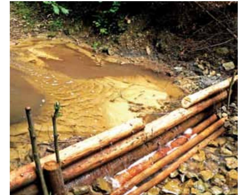
Hrádze v Hervartove i Vyšnej Boca sa napĺňajú erodovaným materiálom. Intenzita napĺňania závisí od stavu poškodenia krajiny. | The check dams in Hervartov and Vyšná Boca are getting filled with eroded material. The filling rate depends on the condition of the devastated landscape.
