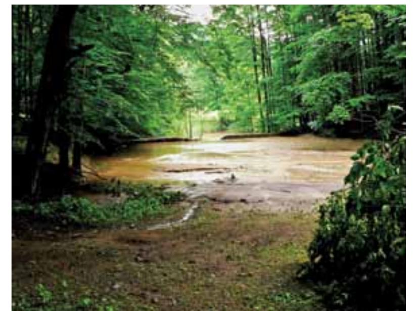
Kamenná hrádzka v nad Pílou sa pri bleskovej povodni v roku 2011 úplne zaniesla. | Stone dam above Píla was completely filled with sediments after flash flood in 2011.
