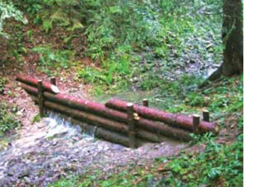
Vhodne vyrezané otvory na hrádzke usmerňuje tok vody počas povodní. | Properly made slits in the check dam rectify the flow direction during floods.
