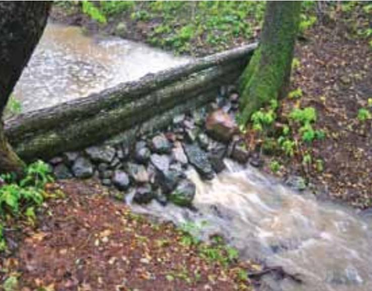
Kamenno-drevená hrádza ukotvená na stromoch je vhodným riešením. | A stone and wood check dam anchored to trees is a suitable solution.
