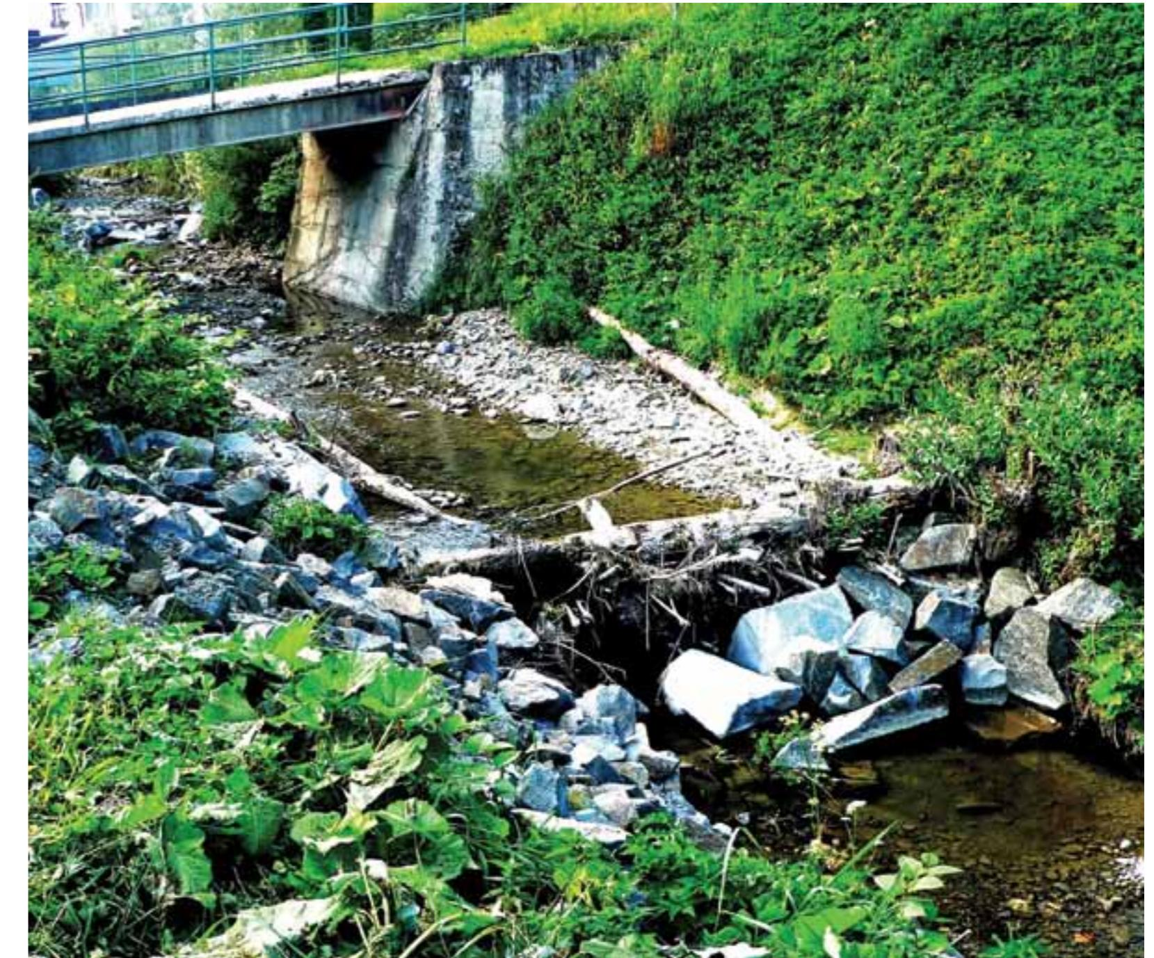
**Prekladaná hrádza v Matysovej, urobená 5 dní pred povodňou, ukázala veľmi rýchlo svoju účinnosť. Zdvihnutie dna stabilizovalo aj piliere mosta, ktorých päty pred povodňou trčali vo vzduchu a hrozili zrutením.** | The interlaced check dam in Matysová constructed five days before a flood proved its effectiveness very quickly. The lifting of the bed also stabilized the pillars of the bridge that was above the water level and there was a risk of collapse before the flood.
