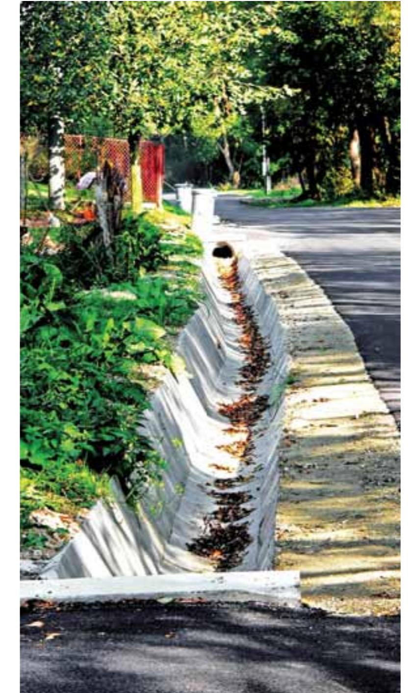
◀ Typická vodná infraštruktúra na zbieranie dažďovej vody zo spevnených plôch v intravilánoch obcí, ako v Malom Šariši, v Čierne na Kysuciach, v Gemerskej Jablonici... | Typical water infrastructure for collecting of rain water from paved surfaces on urban land as in Malý Šariš, in Čierne in Kysuce region, in Gemerská Jablonica...
