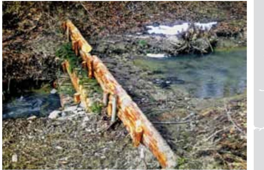
Zachytené sedimenty na prekladanej hrádzí sú dôkazom efektívnosti pri ochrane pred eróziou a povodňami. | Sediment that builds up in interlaced check dams proves effectiveness in protecting from erosion and flooding.
