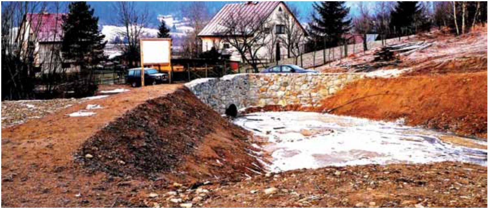
Kamenná murovaná prehrádzka môže mať dnový výpust, ako v Starej Bystrici. | A stone masonry check dam can have a bottom drain as the one in Stará Bystrica.
