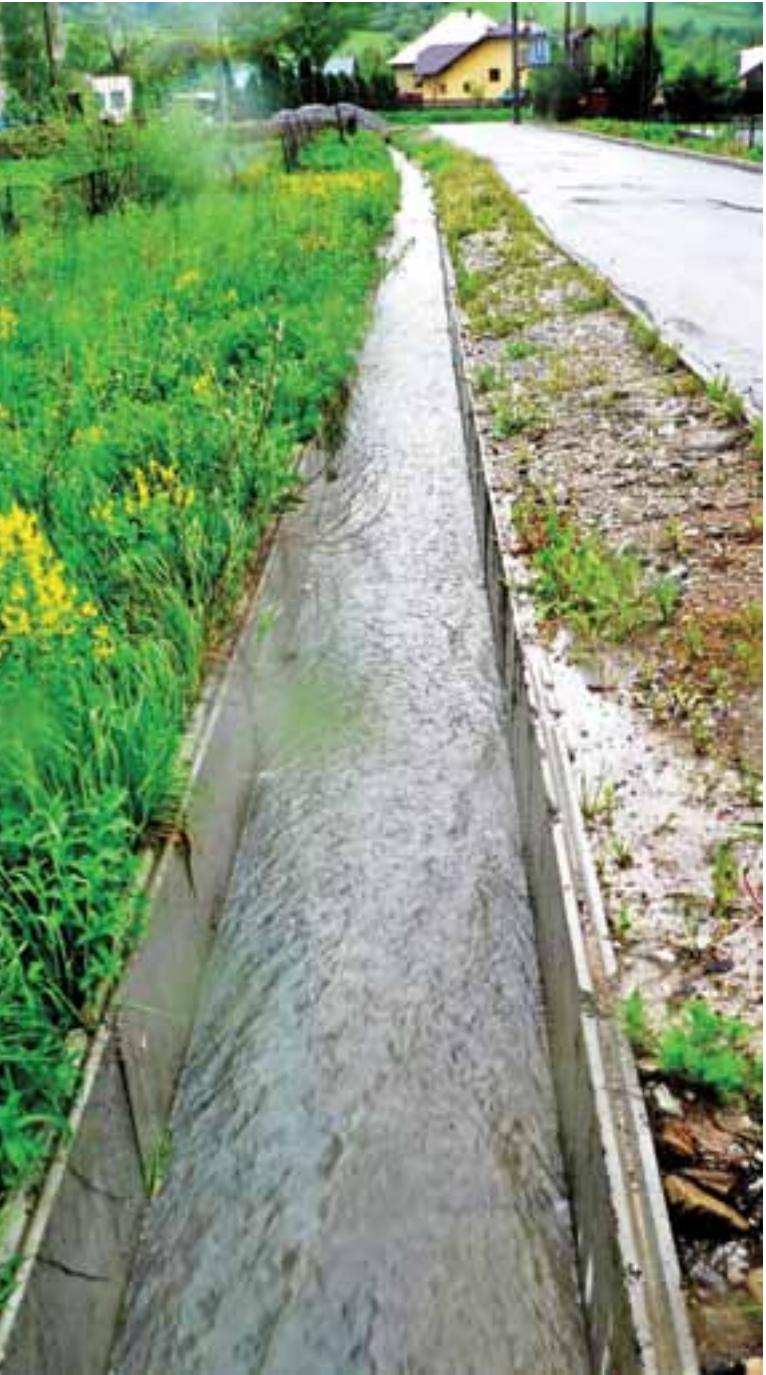
Rigol na rýchlejšie privádzanie povodňovej vody do centra obce v Starej Bystrici v povodí rieky Kysuca. | A gutter bringing flood wave quicker to the centre of the village in Stará Bystrica in the catchment of Kysuca river.
