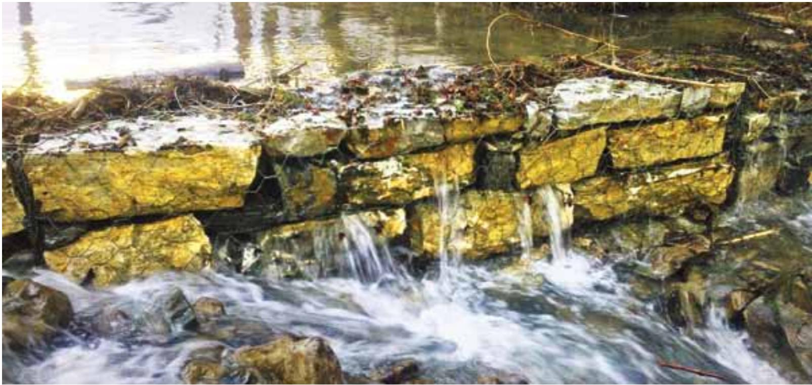
Priepustná kamenná hrádza plní tiež protipovodňovú funkciu. | Permeable stone check dams also perform their flood control function.
