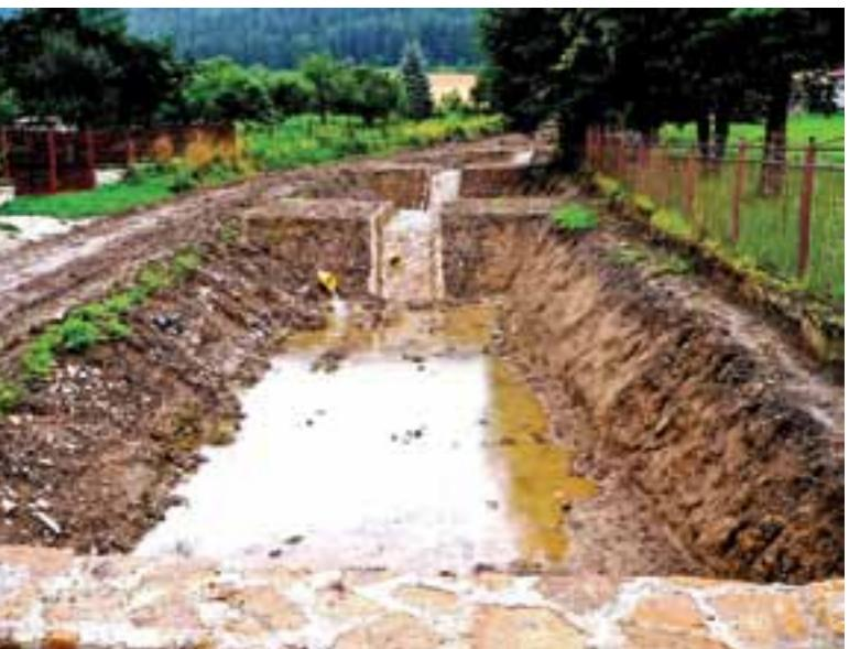
**Kaskáda malých plôch v Granč-Petrovciach vznikla na mieste eróznej ryhy, ktoré bolo miestom pre vynášanie odpadu.** | A cascade of small dips in Granč-Petrovce was constructed in an erosion ditch that was used as a dump for waste disposal.
