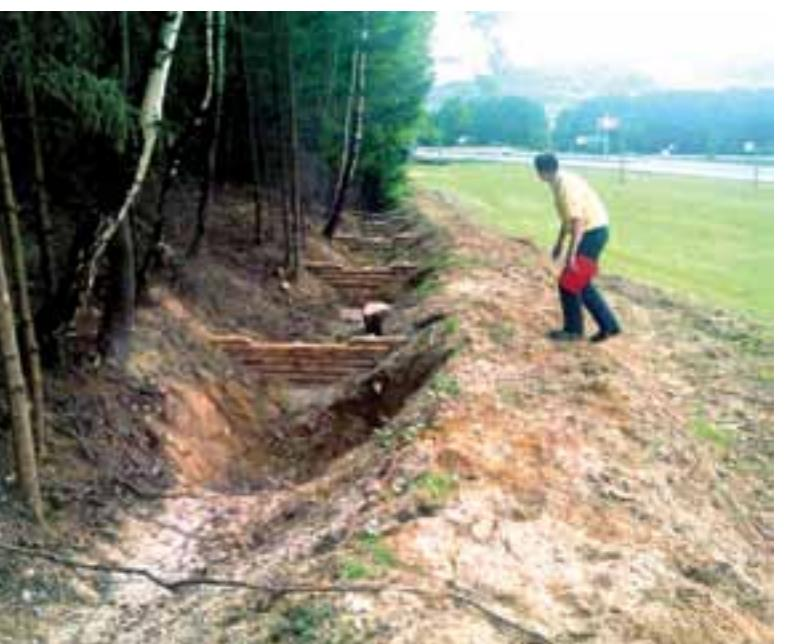
Zemné zasakovacie pásy sú účinné nielen na zadržiavanie dažďovej vody v krajine, ale aj prekážkou škodlivého jazdenia mechanizmami po spádnici: a) a b) Krásna Lúka, c) Matysová, d) Horný Hričov. | Contour trenches are effective not only in retaining rainwater on the land but also in creating a barrier to harmful machinery transport perpendicularly to the contour line: a) and b) Krásna Lúka, c) Matysová, d) Horný Hričov.
