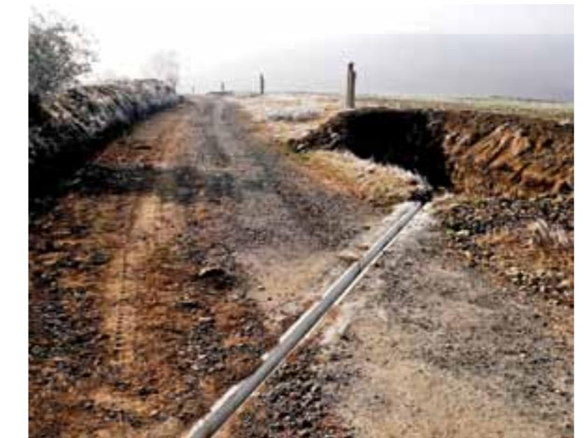
Je vhodné zbierať dažďovú vodu odrážkou do zasakovacej jamy. | It is suitable to capture rainwater with surface cross drains and carry it into infiltration pits.
