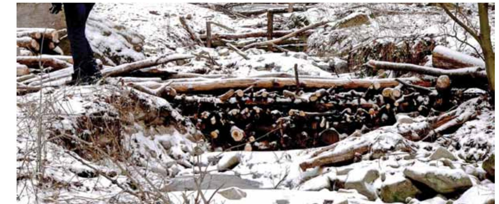
Kaskády prekladaných hrádzí v Dunajove, Povinej či v Malej Lodine fungujú počas povodní ako sítu s usádzaním bahna na konároch, ktoré v ňom budú tvoriť stabilizačnú funkciu ako armatúra v betóne. | During floods the cascades of interlaced check dams in Dunajov, Povina and Malá Lodina perform as a sieve to deposit mud on branches that will get fixed like reinforcement in concrete.
