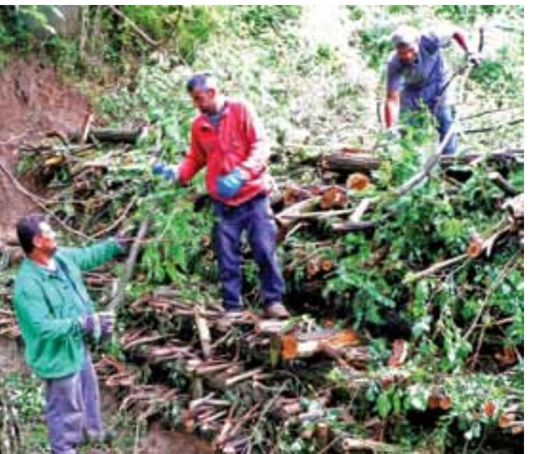
**Tímová práca pri ukladaní haluzín do prekladanej hrádze mala svoju logiku (Hlohovec).** | Teamwork while stacking branches into an interlaced check dam had its logic (Hlohovec).
