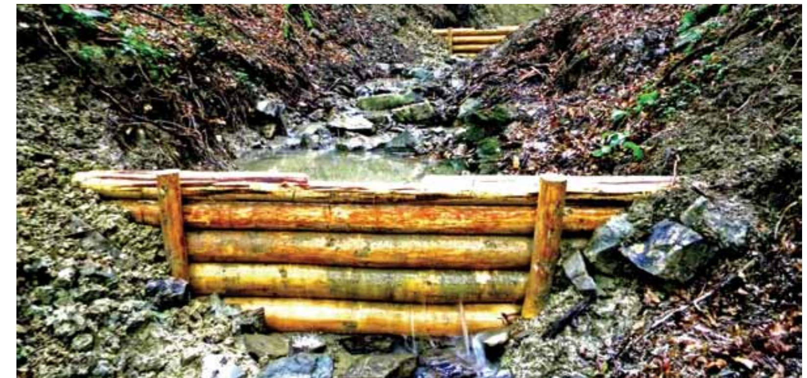
Obyčajné hrádzky na drobných vodných potôčikoch zásadne prispievajú k ochrane pred eróziou a povodňami, ak sú urobené v najvyššie položených roklinách. Regular check dams on small water streams contribute significantly to erosion and flood prevention if they are constructed in the upper sections of gullies.
