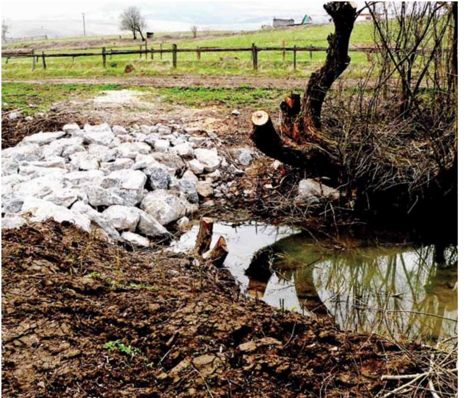
**Princíp kamenných hrádzí spočíva v znížení prieplustnosti koryta, vo vzdúvaní hladiny a v sedimentácii.**
