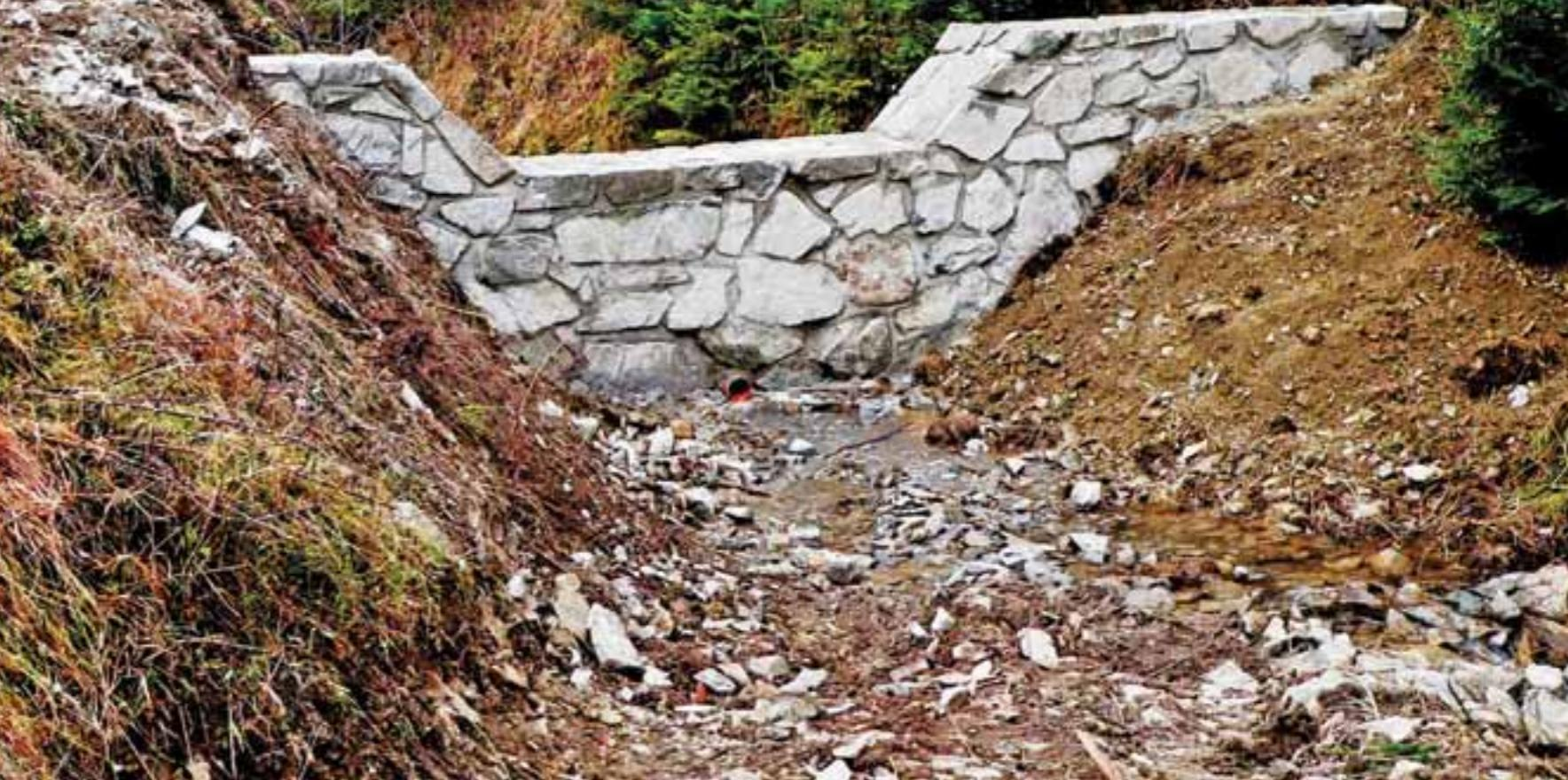
Výšky vybudovaných kamenných hrádzí boli od jedného do troch metrov. | The height of a stone check dams which were build are from one up to three meters.
