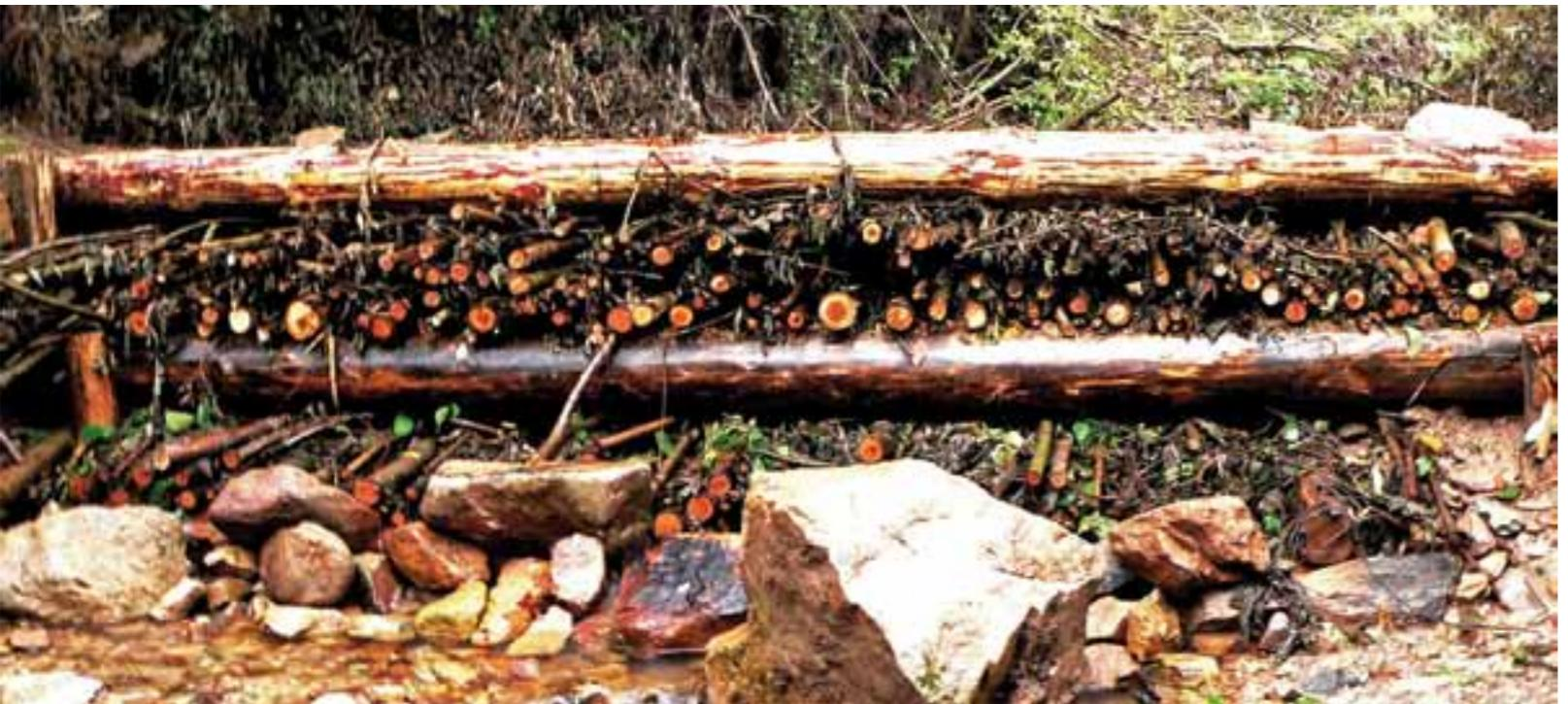
**Sito z prekladaných hrádzí spôsobí, že po zanesení sa drevo v bahne zakonzervuje a tým zvýši trváčnosť na niekoľko desaťročí. Sú to najbezpečnejšie hrádze.** | A sieve made of interlaced check dams will cause their conservation after being silted up with sediments, and thus increasing their life to several decades. These are the safest check dams.
