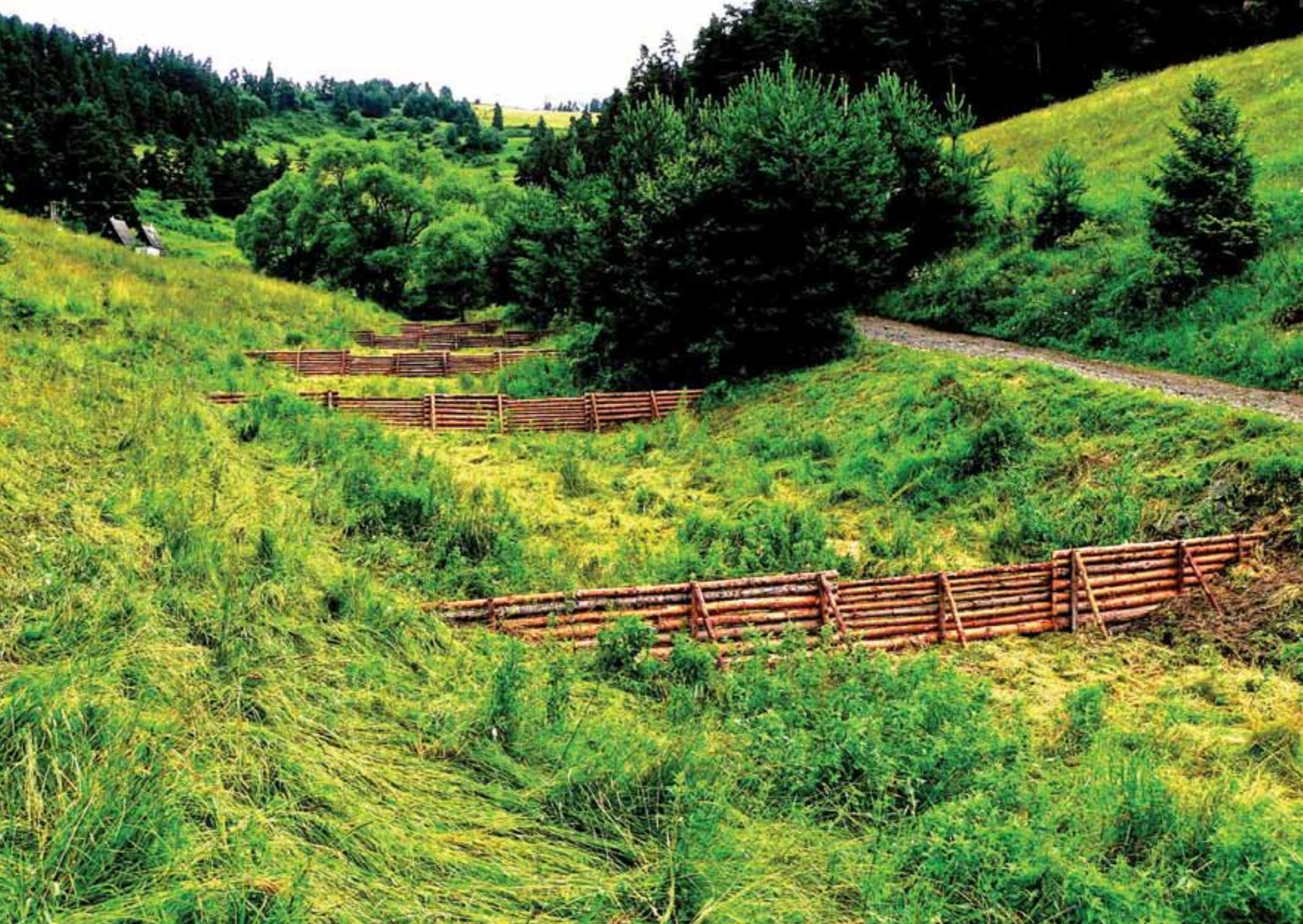
Kaskáda drevencových hrádzí v údolí Draviec na Spiši má zachytiať objem povodňovej vlny z prilahlých svahov a zadržať sedimenty. | A cascade of wooden check dams in the valley in Dravce in the Spiš region should capture the volume of a flood wave from adjacent slopes and sediments.
