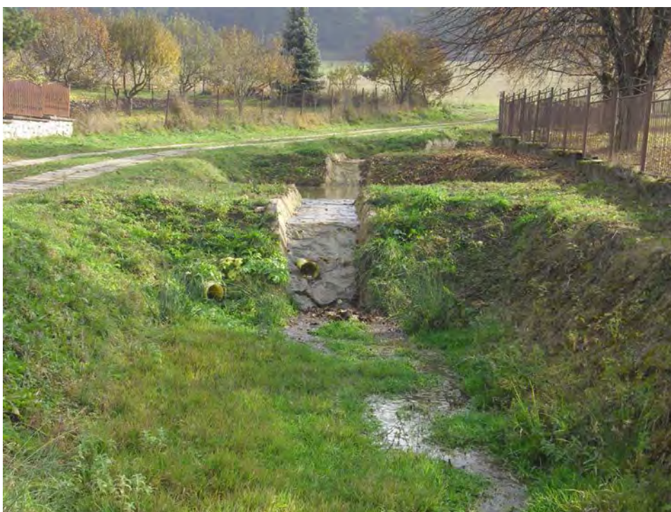
Figur 44. Kjede av fyllingsdammer med støpt/steinsatte overløp. Legg merke til røret gjennom dammen som holder vannstanden under et gitt nivå. I dette tilfellet hadde enkelte dammer vann, mens andre stod tørre i perioder uten regn (Petrovce, foto J. Skauge). Anlegget under flom er vist i Vedlegg 5, fig. 65.
