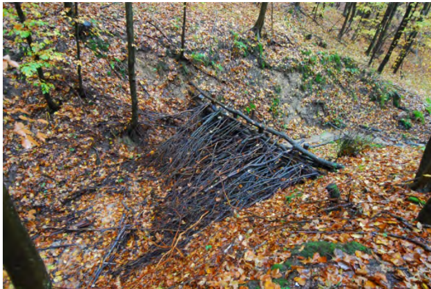
Figur 22. Stokkdammer der kvister er stukket inn mellom stokkene, og der kvistene er forankret med en stokk (høyre foto) (foto K.A. Hoseth og S. Myrabø).
