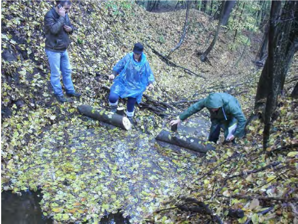
Figur 16. Stokkdam som holder vann etter nedbør (Gruzovce, foto J. Skauge).
