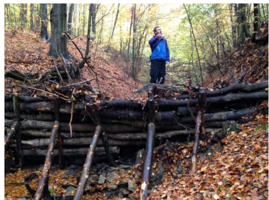
Figur 25. Stokkdam med kvister som er fylt med sedimenter (foto S. Myrabø).
