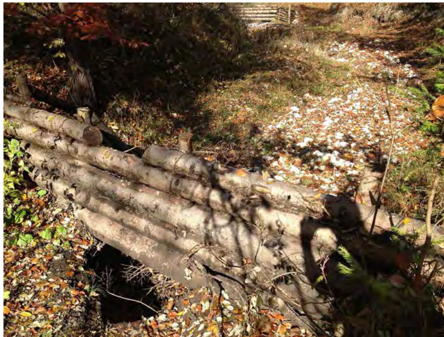
Figur 21. Undergravd stokkdam. Trolig pga overtopping og dårlig fundamentering (foto S. Myrabø).
