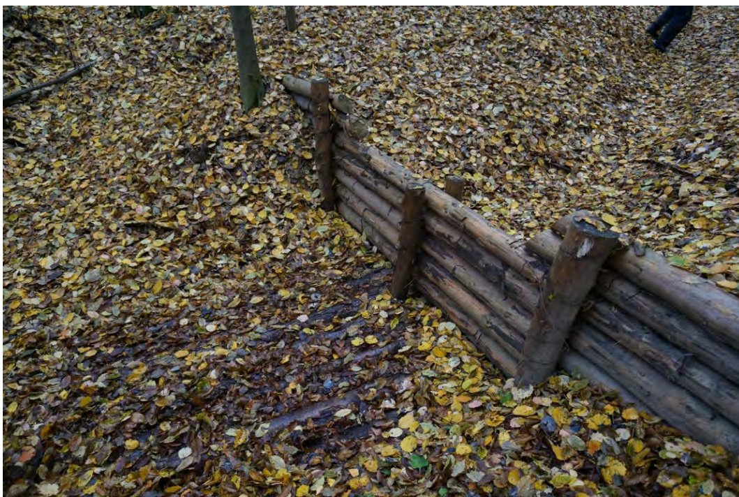
Figur 11. Barka stokker i en stokkdam. Midtpartiet er nedsenket for å styre vannstrømmen ved overtopping. Vannet ledes ned på et stokklag (styrtseng) i foten av anlegget som hindrer graving (Okruhle, foto B.C. Braskerud).
