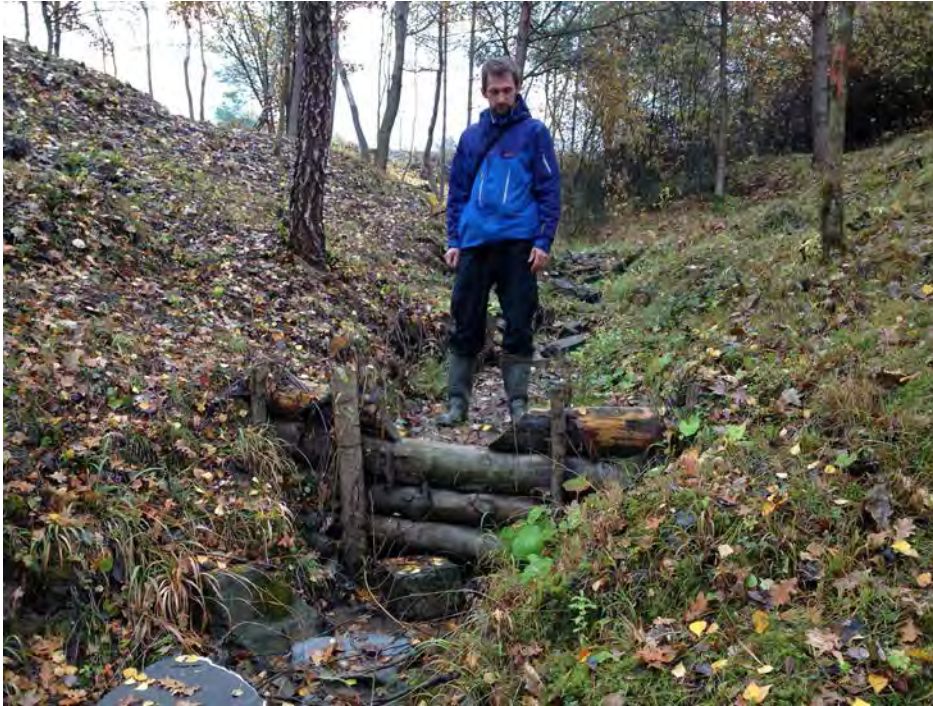
Figur 18. Liten stokkdam som er fylt med sedimenter. Når anlegget er fylt kan en ny liten dam lages noen meter bak den første. På den måten heves terrenget langsomt, fordi erosjonsprosessene stopper (foto S. Myrabø).
