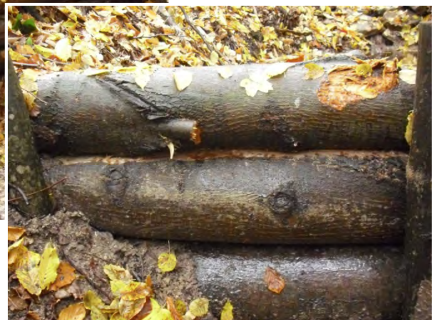
Figur 15. Stokkene er tett sammenføyd og Holder derfor på vannet i en lengre periode (Gruzovce, foto J. Skauge).
