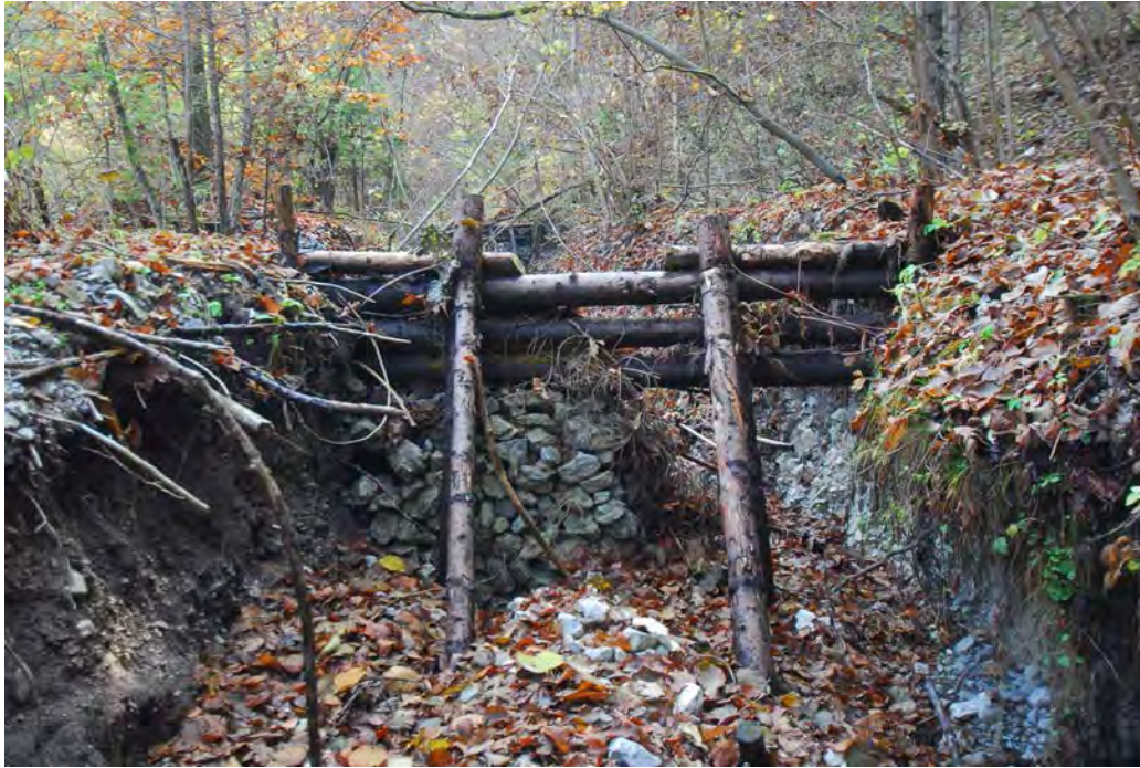
Figur 39. Stein og stokkdam som har kollapse. Trolig har vannet fulgt bekkekanten og erodert denne. Deretter har vannet plukket med seg stein som har hatt for liten størrelse (Smizani, foto K.A. Hoeseth).
