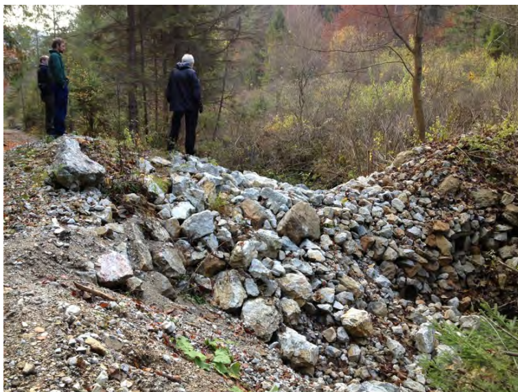
Figur 29. Ren steindam satt sammen av stein med forskjellig størrelse. Et lavt midtparti samler strømmen og reduserer erosjon i sidekantene. Et rør er lagt under dammen, for å sørge for at noe vann garantert kommer igjennom anlegget. Vi er usikker på om utforming og steinstørrelse er godt nok tilpasset en stor flom (foto S. Myrabø)
