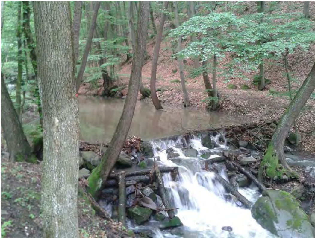
Figur 62. Steindam overtoppes. Skogsavfall og sedimenter holdes tilbake.
