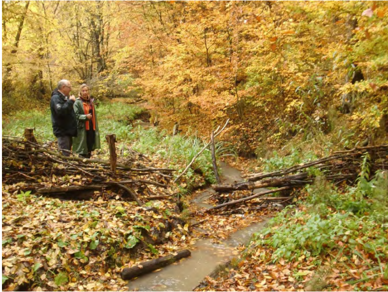
Figur 10. Greinterskel som har brutt sammen. Trolig har vannmengdene vært for store for den svake konstruksjonen (foto T. Kval).
