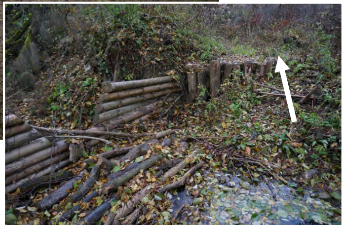
Figur 48. Flomdam som ligger ved siden av bekken. En stokkdam med V-overløp ligger i bekken. Ved flom ledes en delstrøm inn i flomdammen. Tre tilsvarende dammer lå nedstrøms (Okruhle, foto B.C. Braskerud).
