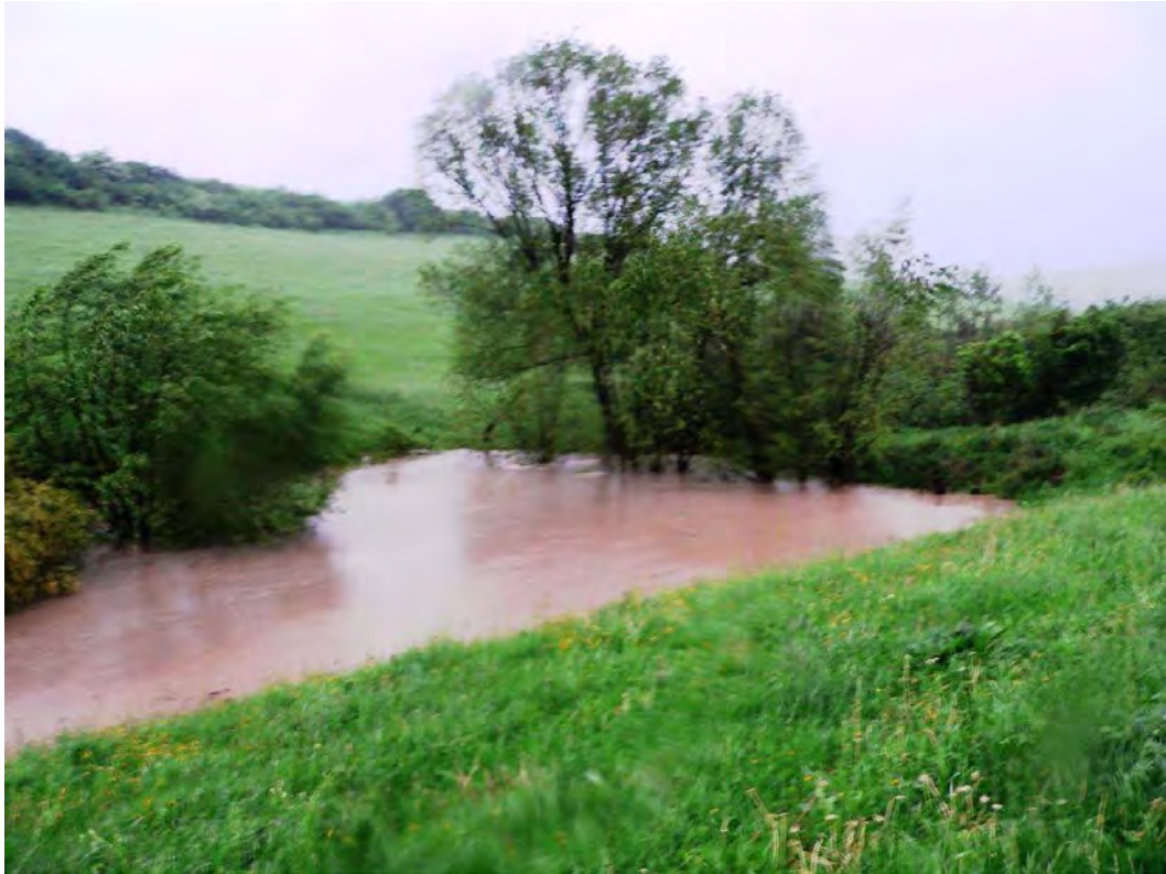
Figur 60. Terskel demmer opp vann midlertidig.
