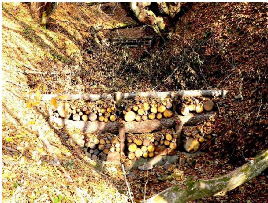
Figur 8. Kvistdammer legges i kaskader i bekkedragene. Skulle ett anlegg bryte sammen ved store vannmengder, vil det neste stå klart til å fange det opp (foto M. Kravcik).
