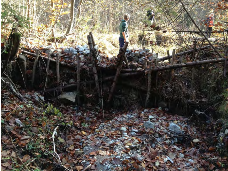
Figur 35. En enklere versjon av damtypen over, har brutt sammen. Rammeverket av stokker er for svakt og tilfeldig satt sammen. Trolig har vannet erodert bekkekanten mellom stein og jord på høyre side, og fått dammen til å kollapse (foto S. Myrabø).
