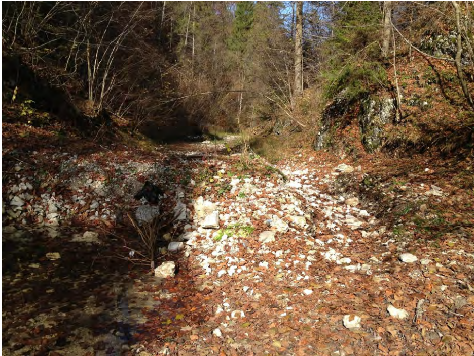
Figur 32. Flomvannføring har tatt hele steindammen. For små stein var benyttet (Foto S. Myrabø).
