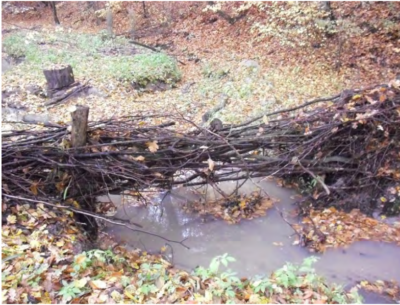
Figur 9. Greinterskel som er undergravd. En svakhet med anleggstypen er at vann som renner under kvistene kan starte bunnsenking som forplanter seg oppover vassdraget (Baskovce, foto J. Skauge)
