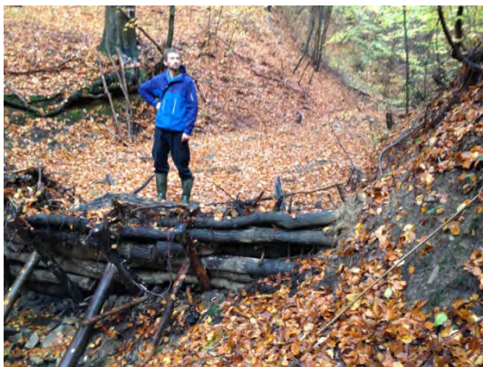
Figur 25. Stokkdam med kvister som er fylt med sedimenter (foto S. Myrabø).
