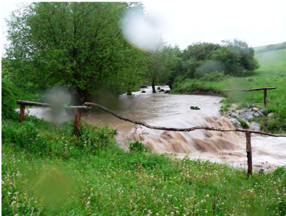
Figur 58. Flomvannføring. Terskel lager vannspeil og reduserer erosjon i elva.
