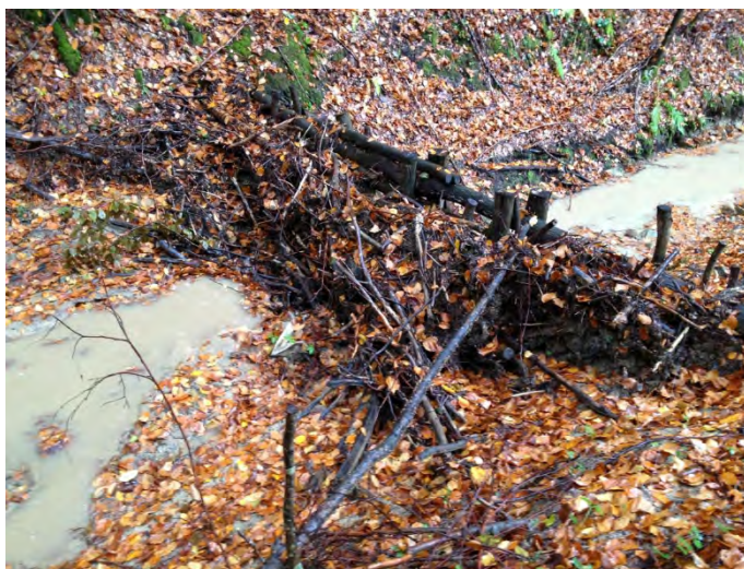
Figur 23. Stokkdam med kvister som har vært utsatt for stor avrenning. Kvistene er presset opp mot dammen, men holder godt på vann og sedimenter. Rot i kvisthaugen kunne vært unngått ved bruk av stokk som holder kvistene nede (høyre foto) (foto S. Myrabø).
