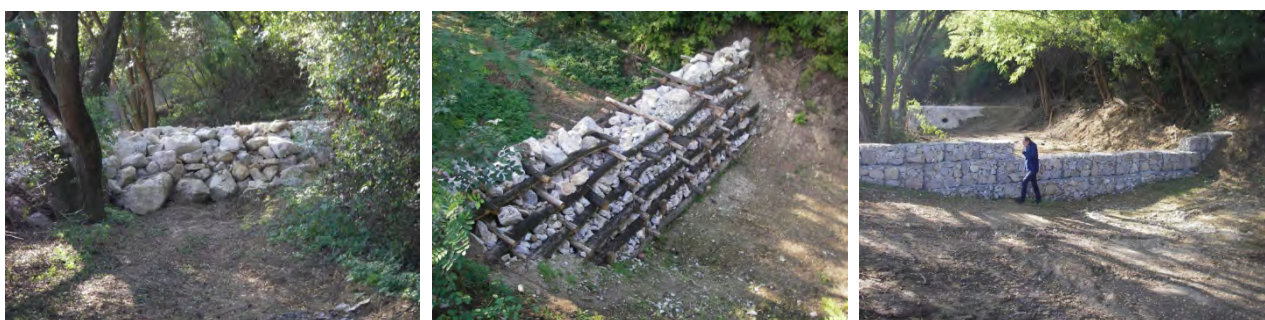
Figur 28. Tre typer steindammer (fra venstre til høyre): Ren steindam, kistedam ("løs" type) og gabiondam. Alle foto fra et forsøksfelt fra Vislava i vest-Slovakia. (foto B.C. Braskerud).
