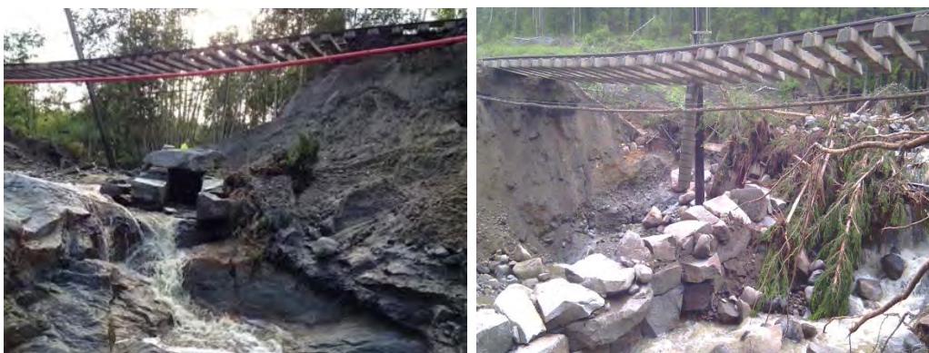
Fig. 1. Fyllinga har kollapset fordi kulverten hadde for liten kapasitet. Den steinsatte kulverten står fremdeles (foto: S. Myrabø)
