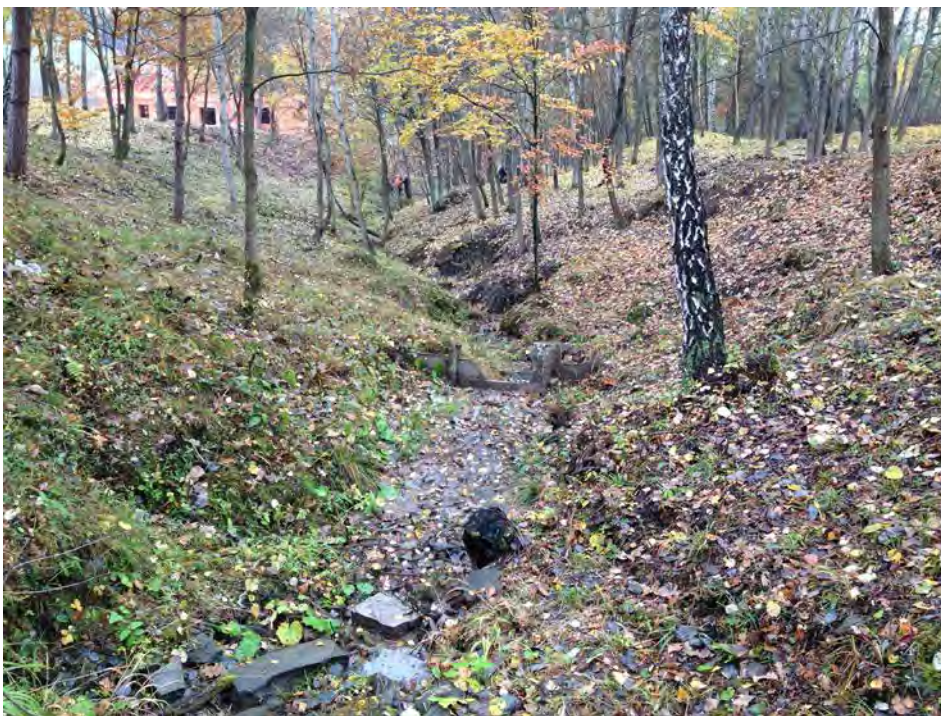
Figur 19. Små terskler anlagt for å redusere erosjonen i landskapet (samme sted som fig. 18, foto S. Myrabø). Terskelen sentralt i bildet er laget i grove planker/bjelker.
