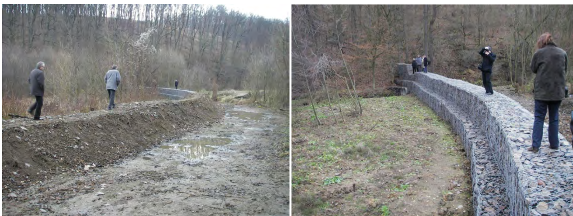
Figur 41. Jordvoll som går over i en gabiondam tilrettelagt for neddemming av store areal ved flom (foto B.C. Braskerud).
