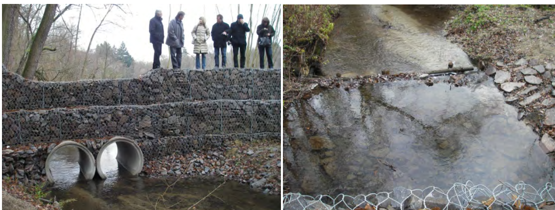
Figur 42. Samme sted som fig. 41. Bekkevannet passerer gjennom to nedsenkede rør for fri passasje av vann og fisk ved lavvannføring. Få meter nedstrøms stikkrennene er det laget en lav steinsatt dam for å lette fiskepassasjen, og forhindre undergraving av gabiondammen hvis den overtoppes (foto B.C. Braskerud).
