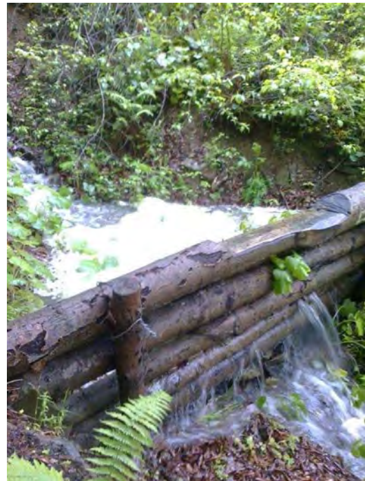
Figur 61. Stokkdammer samler opp sediment og skrot. Dammene er permeable, dvs. vann slippes igjennom mellom stokkene. Dermed reduseres vannhastigheten.
