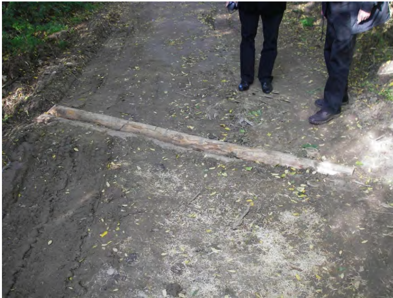
Figur 52. Tømmerrenne som leder vann kontrollert over vegbanen (foto B.C. Braskerud).
