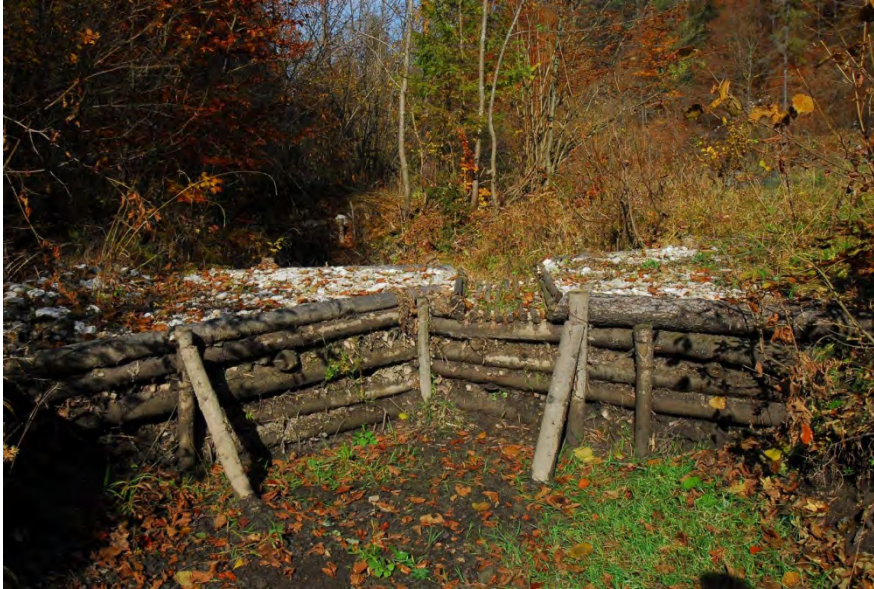
Figur 33. Stein lagt i ramme av tre (kistedam). Vannet renner mot oss. Overløpet er beskyttet av tynnere trestokker (Smizani, foto K.A. Hoseth).
