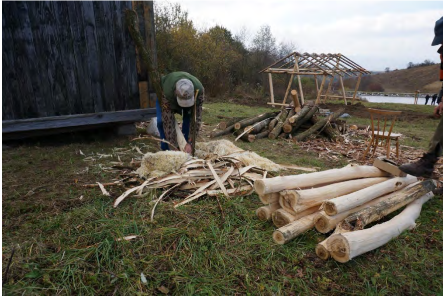
Figur 55. Barking av trevirke kan forlenge stokkenes levetid hevdet slovakene (Dubrava, foto B.C. Braskerud).
