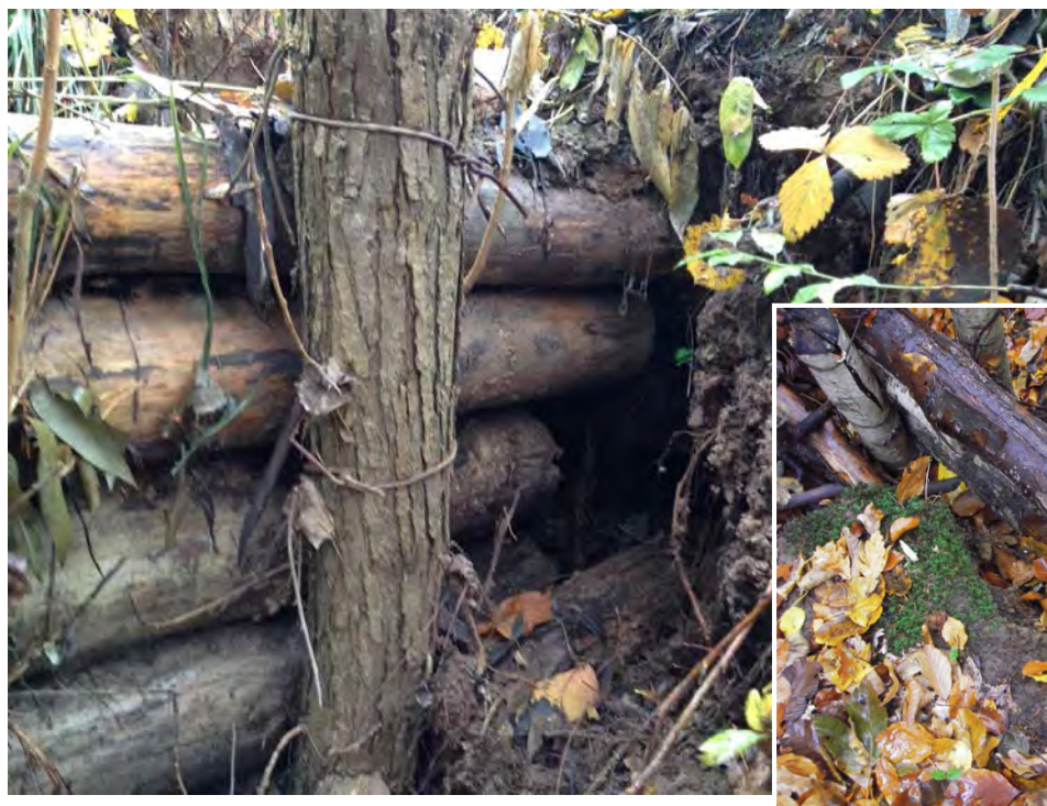
Figur 20. Vannet har gravd rundt endestokkene i bekkekanten. Bildet til høyre viser begynnelende graving rundt toppstokken. Vannet må ledes over dammens midtparti og ikke sidekantene (foto S. Myrabø og B.C. Braskerud).
