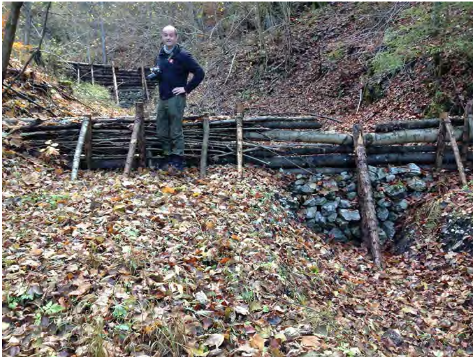
Figur 36. Kombinasjon av ren steindam lagt i et uttørket bekkeleie og en stokkdam over. Et enda høyere anlegg sees i bakgrunnen (foto S. Myrabø).
