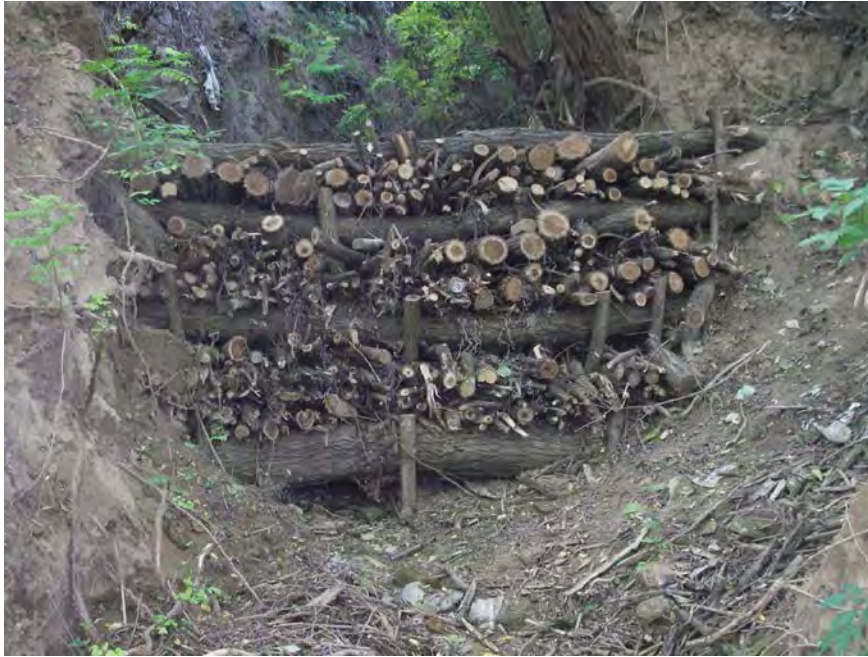
Figur 7. Kvistdam som er montert i et stort erosjonsspor. Legg merke til glippen under bunnstokken. Her vil vann kunne grave. I Slovakia er selv "store" nedbørfelt uten fast årlig vannføring. Ved styrtregn er det mulig at kvisthaugen kan dempe vannstrømmen så mye at erosjonsrisikoen under bunnstokken er liten. Vi så imidlertid flere eksempler på at dette ikke var tilfelle (bilde fra Vislava i vest-Slovakia, foto B.C. Braskerud).
