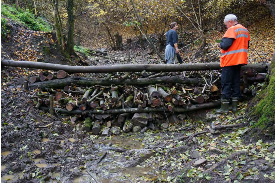
Figur 5. Kvistdam med såle av stor stein. Denne dammen var den siste i en kaskade av stokkdammer som ble montert etter en stor hendelse (foto B.C. Braskerud). Et potensielt sårbart punkt er den lave høyden på venstre side mot skråningen. Her vil det kunne renne mye vann ved styrtregn, som kan grave. Det laveste punktet må være sentralt plassert.
