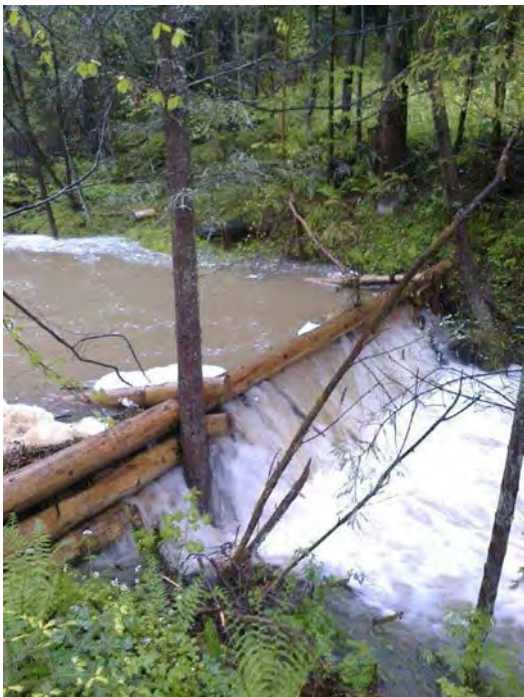
Figur 63. Barkede stokkdammer under flomvannføring. Høyre var kanskje en kombinasjonsdam med stein, og virker undergravet (jmf. fig. 36). Anlegget virker likevel noe flomdempende.
