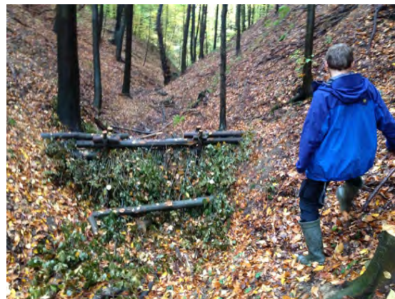
Figur 22. Stokkdammer der kvister er stukket inn mellom stokkene, og der kvistene er forankret med en stokk (høyre foto) (foto K.A. Hoseth og S. Myrabø).
