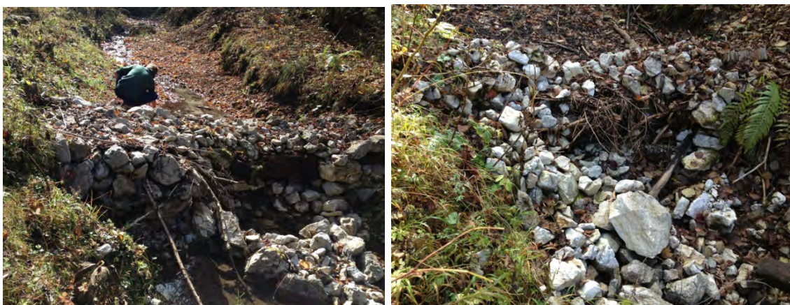
Figur 31. To steindammer der det ytre beskyttende steinlaget er i ferd med å bryte sammen. Steinstørrelsen har nok vært for liten (foto S. Myrabø).
