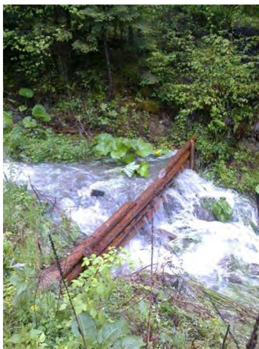
Figur 63. Barkede stokkdammer under flomvannføring. Høyre var kanskje en kombinasjonsdam med stein, og virker undergravet (jmf. fig. 36). Anlegget virker likevel noe flomdempende.
