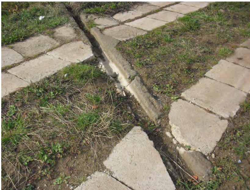
Figur 53. Støpt renne på landbruksveg har samme funksjon som tømmerrenna over. Avstanden mellom rennene må ikke bli for stor. (Petrovce foto J. Skauge).
