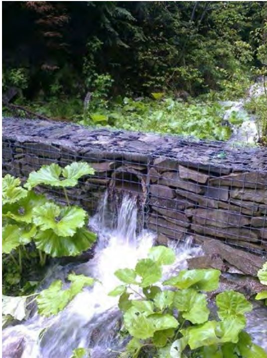
Figur 64. Gabinondammer med liten og stor vannføring.
