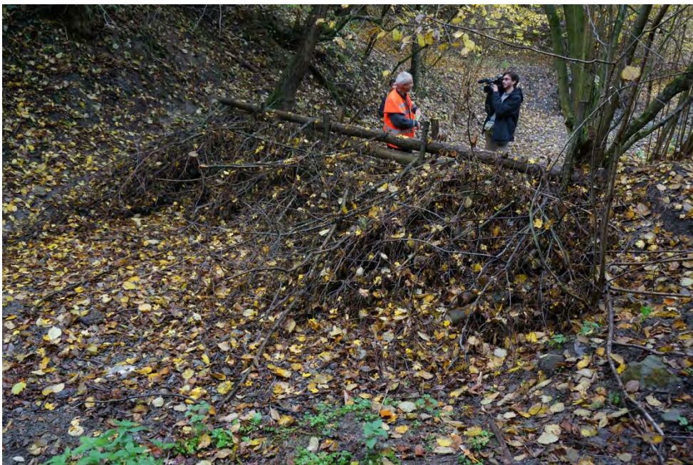
Figur 27. Kvistene kan legges mot sidekanter og bunnen. Da vil vannhastigheten reduseres i dette området, og problemer med erosjon i bekkekantene minimeres. Vannstrømmen vil fortrinnsvis ledes sentralt i anlegget (foto K.A. Hoseth).
