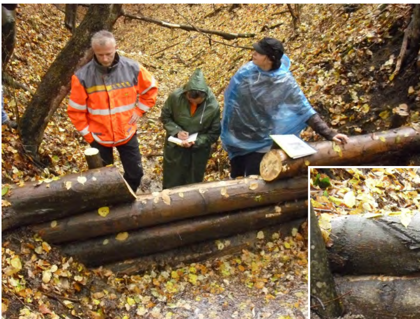
Figur 15. Stokkene er tett sammenføyd og Holder derfor på vannet i en lengre periode (Gruzovce, foto J. Skauge).
