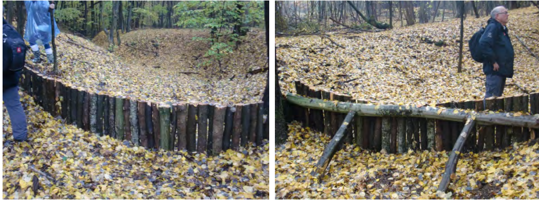
Figur 12. Trespuntterskel med et tydelig lavt punkt sentralt plassert. Tverrstokk med støttestokker avstiver terskelen (foto T. Kval).
