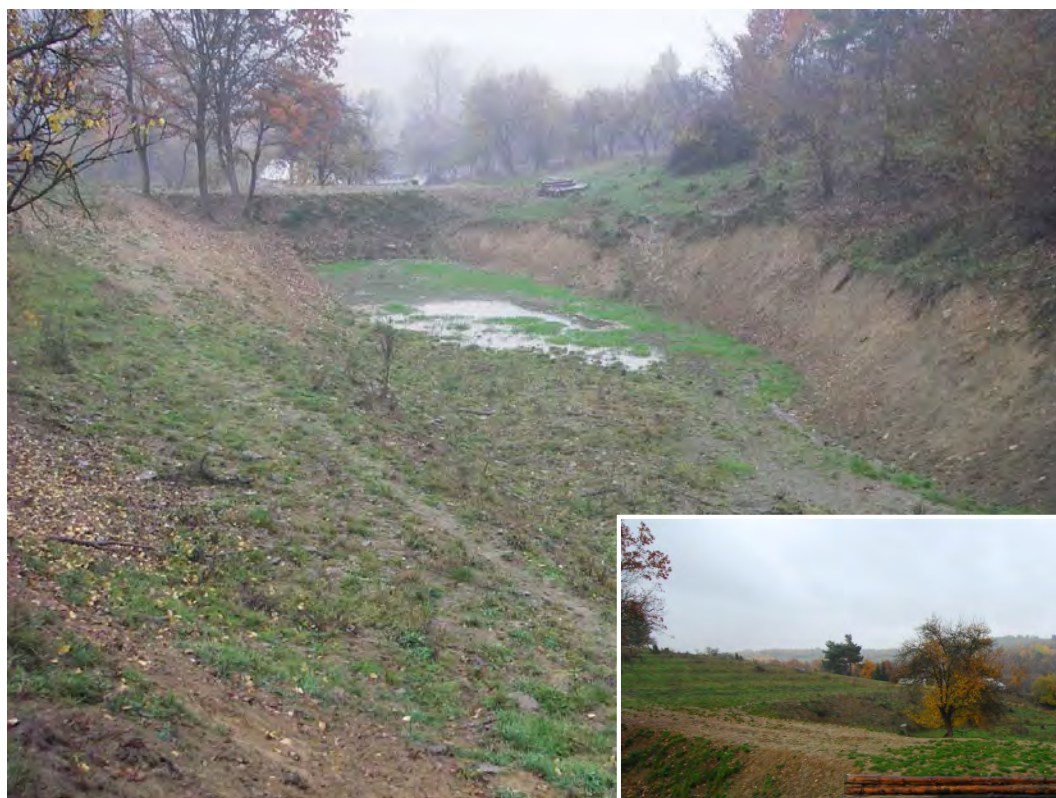
Figur 43. Fyllingsdam for flomvannhåndtering Anlegget har rør igjennom dambunnen, og et flomoverløp i tre (Roztoky, foto Braskerud og K.A. Hoseth).
