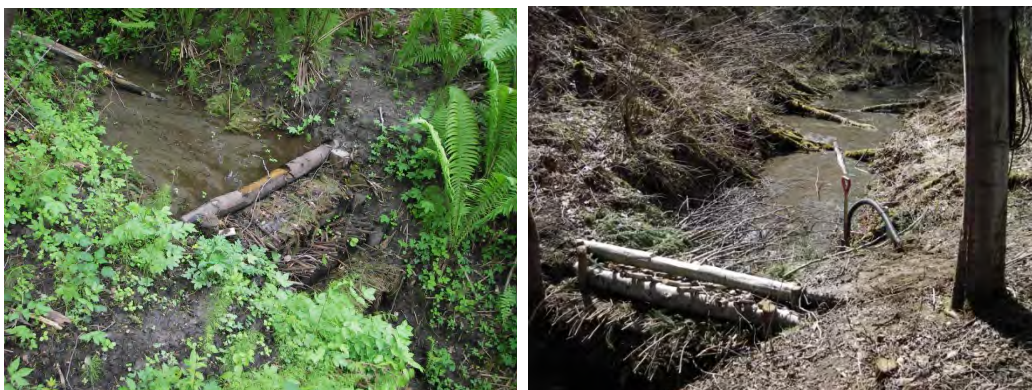
Fig. 2. Kvistdammer laget av stokker og greiner ved Minnesund stasjon. Vi har allerede opplevde suksess og feil på anleggene vi laget i 2012, og ønsket å lære mer om hvordan robust anlegg kunne lages (foto: B.C. Braskerud)
