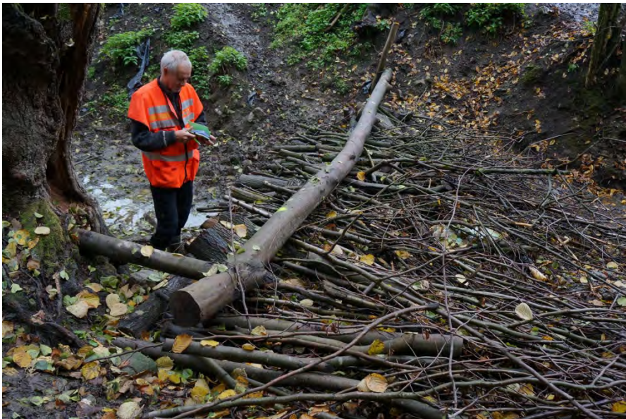
Figur 6. Samme kvistdam som fig. 5. Kvistene legges så tett som mulig mot vannretningen. En toppstokk forankrer det hele (foto B.C. Braskerud).
