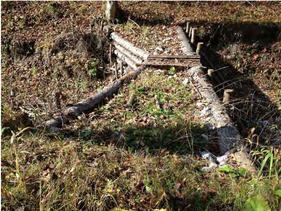
Figur 34. Samme type som i figur 33. Vannet renner i et lavere parti sentralt i terskelen (foto S. Myrabø). På sikt kan kanskje vegetasjon invadere dammen og få den til å gå mer i ett med landskapet, samt forsterke den.
