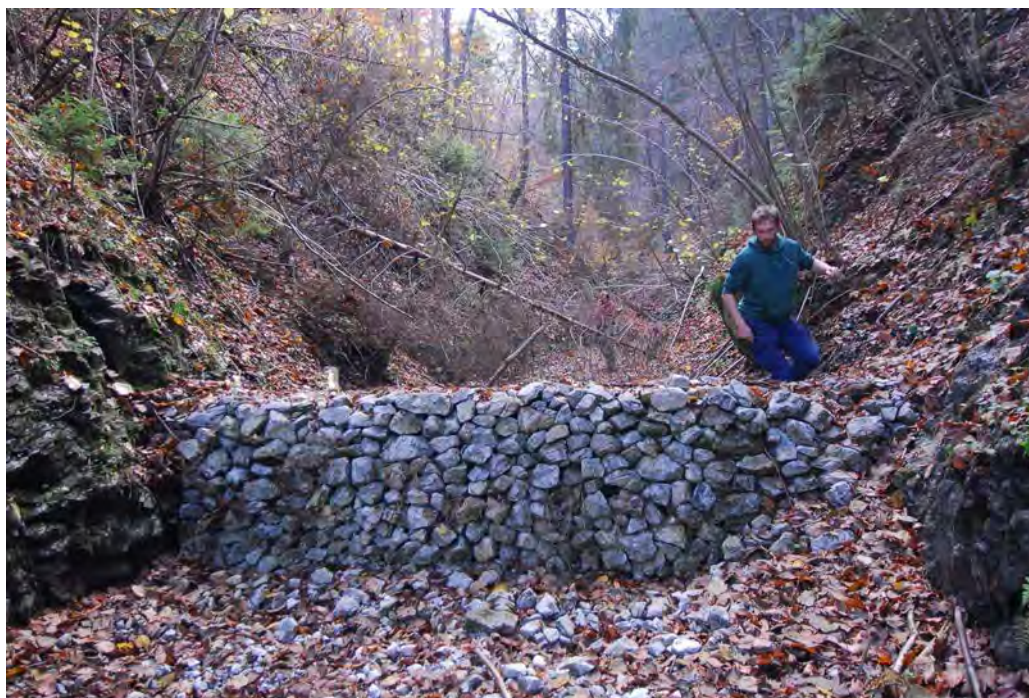
Figur 30. Vakker, håndlagt steindam i uttørket bekkeleie mellom to fjellknauser. Vi vurderer at steinstørrelsen, forankring og utforming ikke er godt nok tilpasset overtopping ved stor flom (foto K.A. Hoseth).
