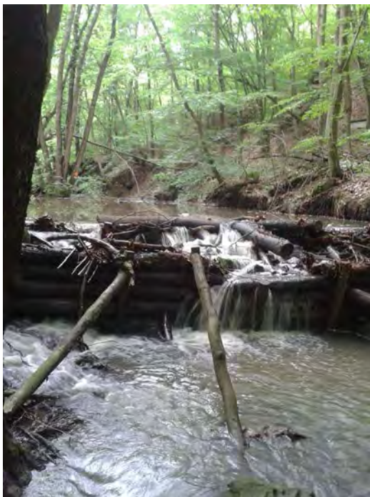
Figur 61. Stokkdammer samler opp sediment og skrot. Dammene er permeable, dvs. vann slippes igjennom mellom stokkene. Dermed reduseres vannhastigheten.
