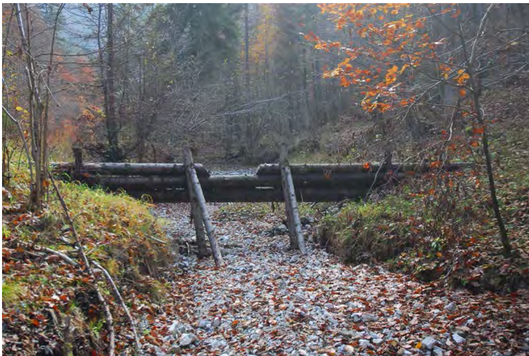
Figur 40. Hele steindelen er erodert vekk. Stokkene er godt forankret og står (Smizani, foto K.A. Hoeseth).
