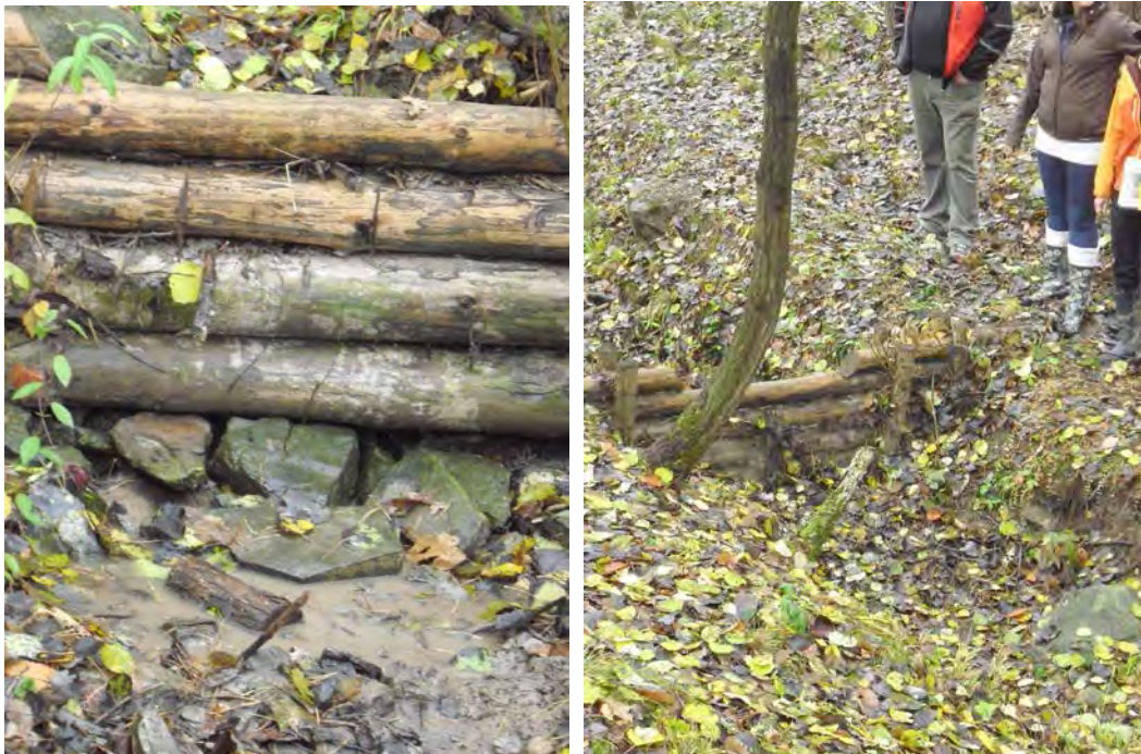
Figur 17. Stein er lagt under bunnstokken for å hindre graving ved stor vannføring (venstre bilde). Tilbakeholdingene av sedimenter har vært god. En stokkdam kan godt lages i små dråg (høyre bilde). (Nizny Kruzlova, foto J. Skauge).
