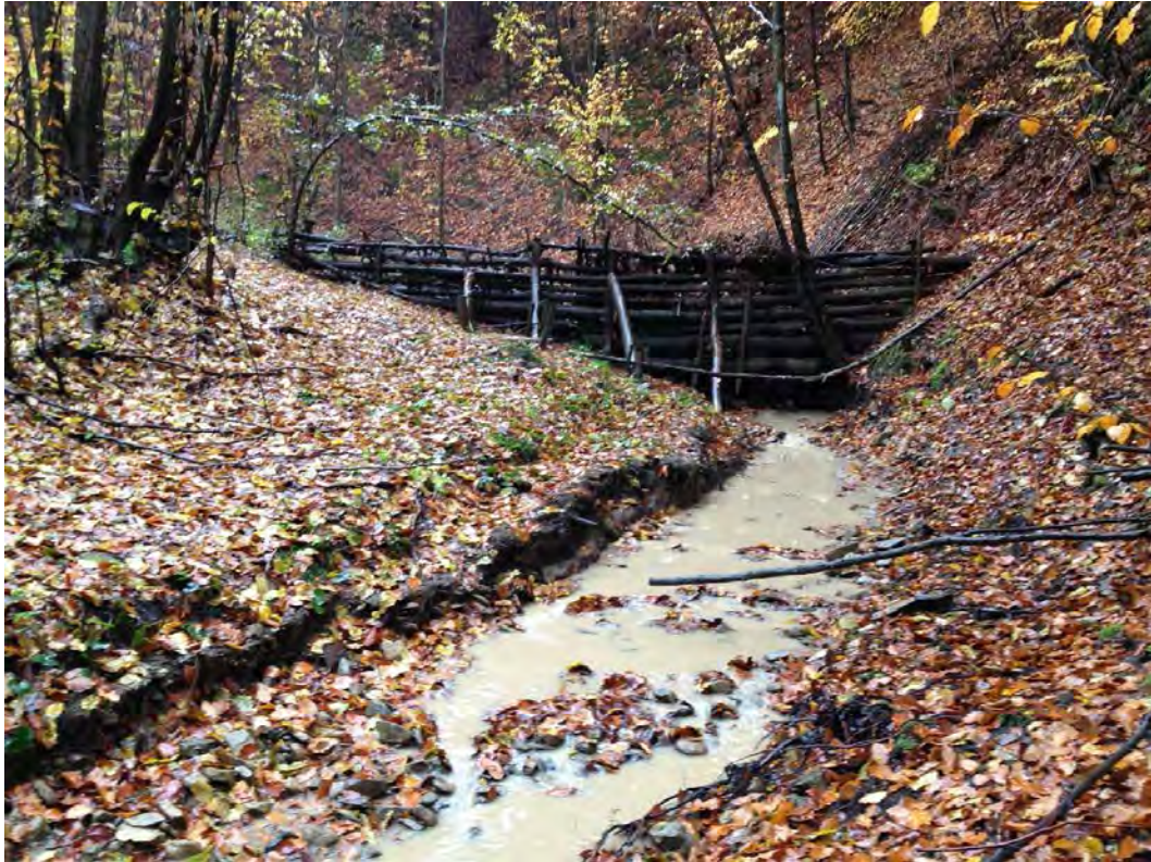
Figur 24. Meget høy stokkdam med kvister (2-3 m). Flere slike var laget etter hverandre. Ved en hendelse ble anleggene overtoppet. De tålte påkjeningen. Legg merke til støttestokkene i forkant. I noen områder ble de brukt, andre ikke (foto S. Myrabø).
