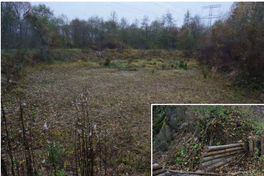
Figur 48. Flomdam som ligger ved siden av bekken. En stokkdam med V-overløp ligger i bekken. Ved flom ledes en delstrøm inn i flomdammen. Tre tilsvarende dammer lå nedstrøms (Okruhle, foto B.C. Braskerud).
