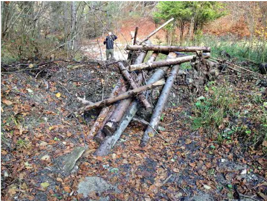
Figur 38. Samme dam som i figur 37. Dammen har holdt både sediment og trevirke. Godt håndarbeid fungerer (foto S. Myrabø).
