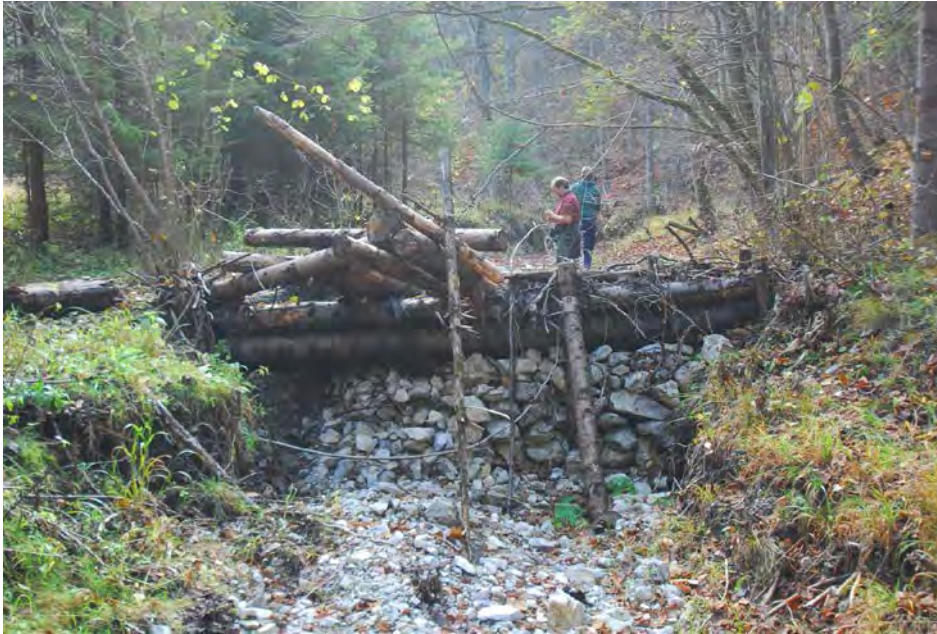
Figur 37. Steindam med stokker som har tålt en trøkk. Flomvann har ført trevirke nedstrøms (rester av dam som har kollapset?), men dammen har stått (Smizani, foto K.A. Hoseth).
